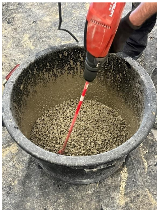
Slika 12: Spravljanje betonske mješavine ručnom miješalicom (izvor: vlastita fotografija)
