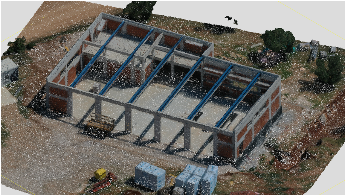
Slika 24 Pogled s prednje strane na oblak točaka Građevine 1
