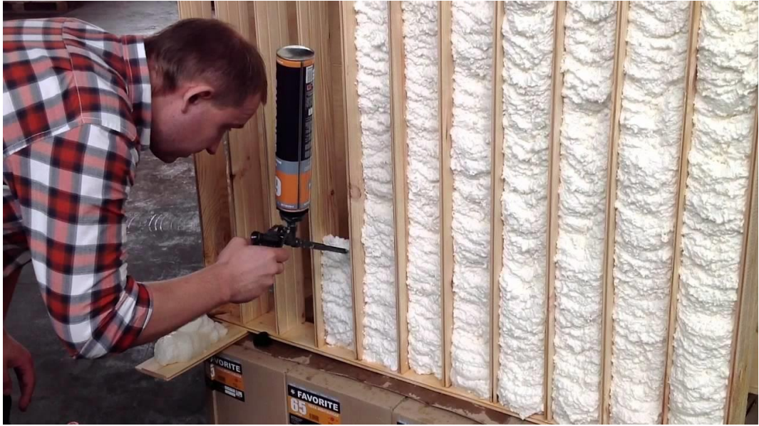
Slika 7: Izolacija poliuretanskom pjenom [34]
