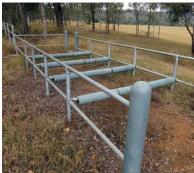
Slika 44: Prikaz metalnih prepreka za prelaženje obloženih gumom [10]
