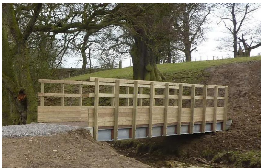
Slika 4: Konjanički most izveden s parapetom i ispunom [14]
