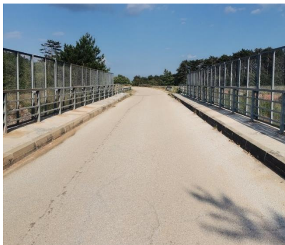
Slika 55: Gazna površina mosta i prilazne staze (ceste)
