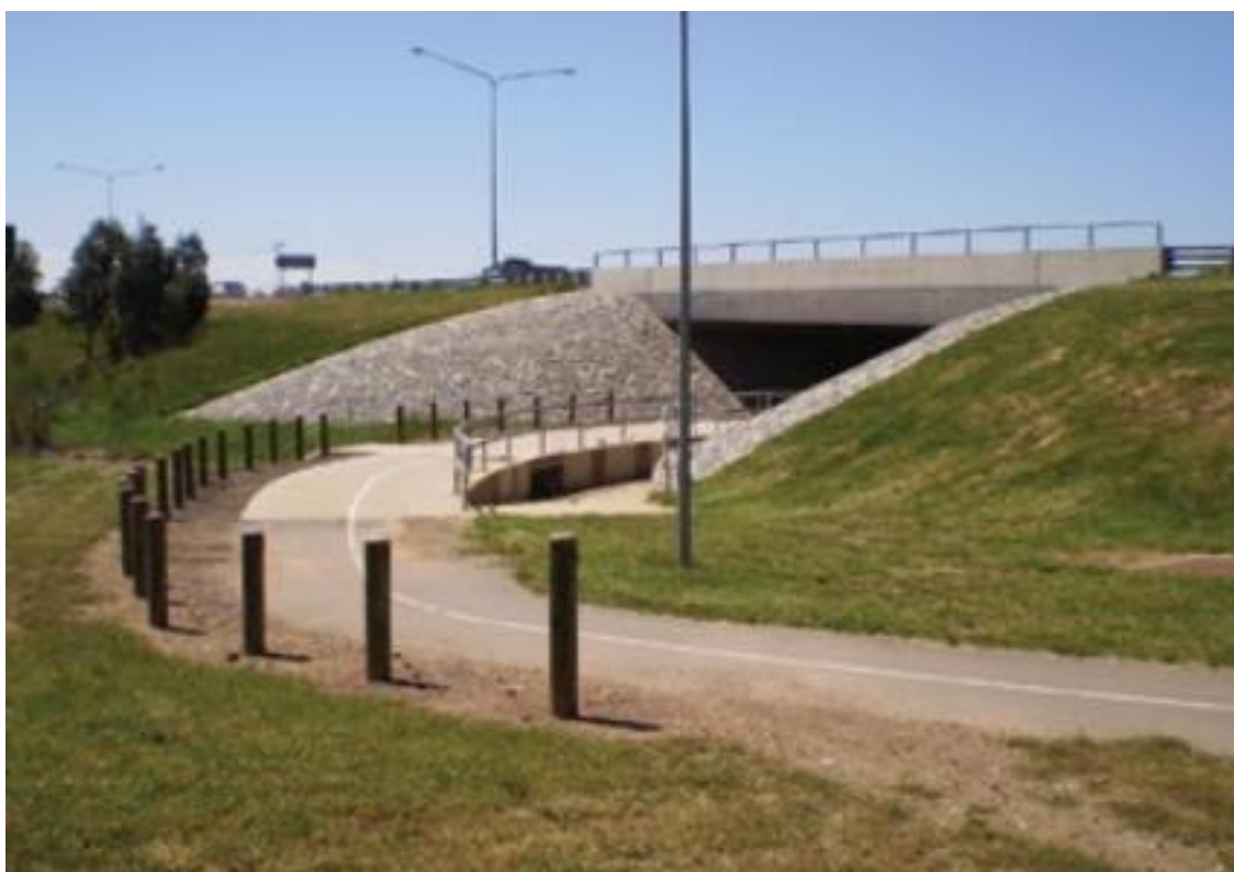
Slika 8: Podvožnjak s odvojenom stazom za jahače [10]
