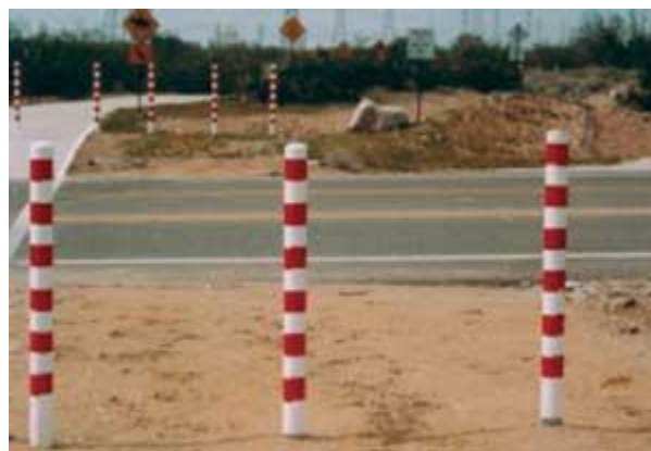
Slika 14: Prikaz postavljanja stupića na ulazu u stazu [18]
