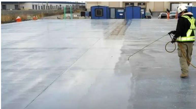
Slika 4. Njega betona tekućom membranom[12]
