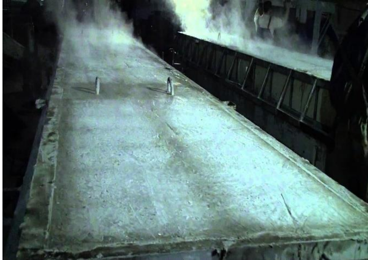
Slika 7. Njega betona zaparivanjem[16]
