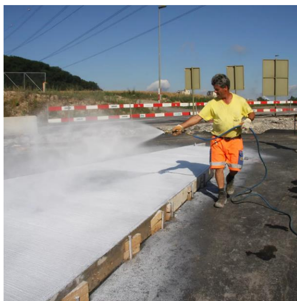
Slika 2. Vlaženje betona prskanjem [9]
