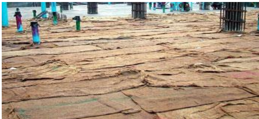
Slika 6. Njega svježeg betona pokrivanjem mokrom tkaninom [14]
