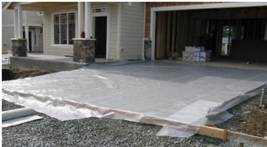
Slika 3. Njega korištenjem plastične folije [11]
