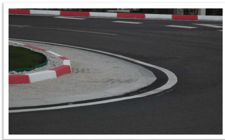
Slika 16. Kružni kolnik i povozni dio središnjeg otoka [7]
