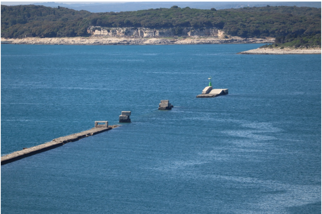
Slika 5: Pogled na pulski lukobran s dimnjaka kotlovnice na poluotoku Musilu
