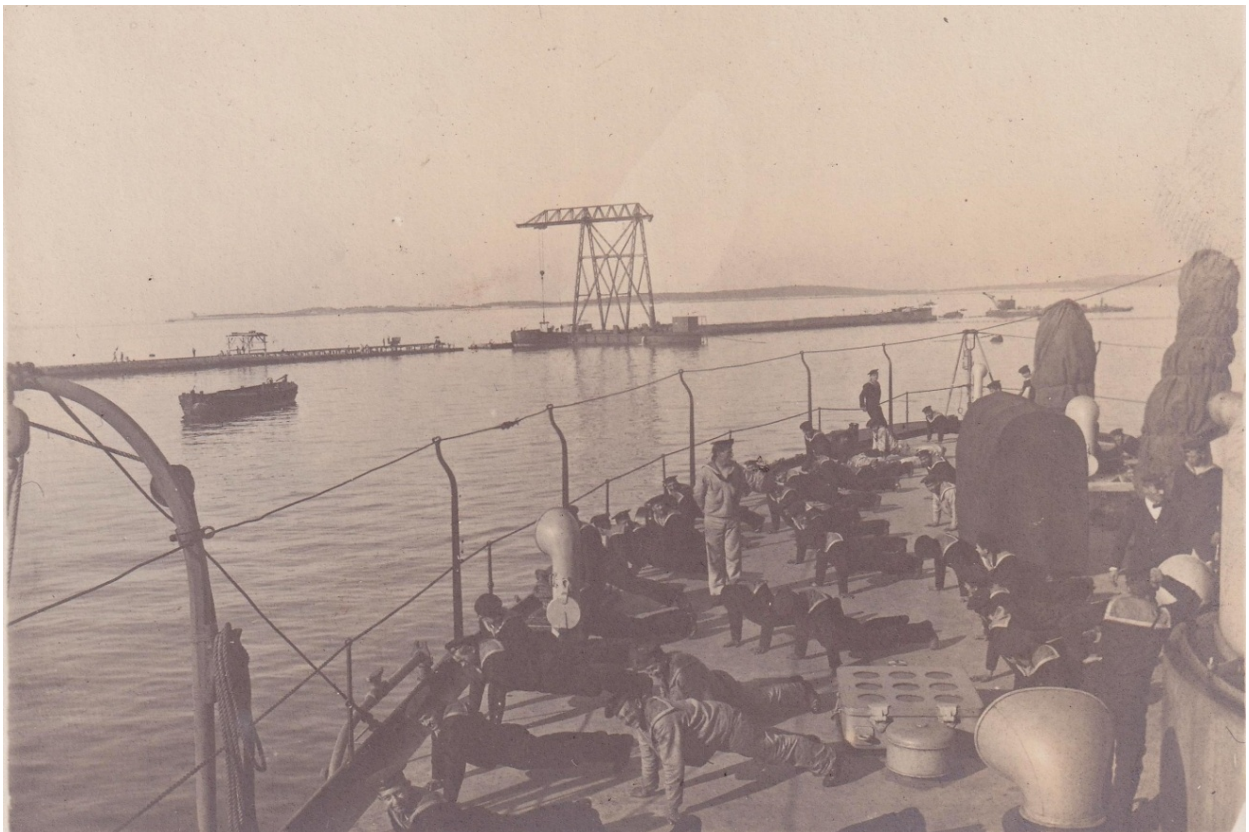
Slika 3: Pogled na gradnju Pulskog lukobrana 1910. – 1914. godine s palube bojnog broda SMS Babenberg (privatna kolekcija fotografija Nikole Pajića)
