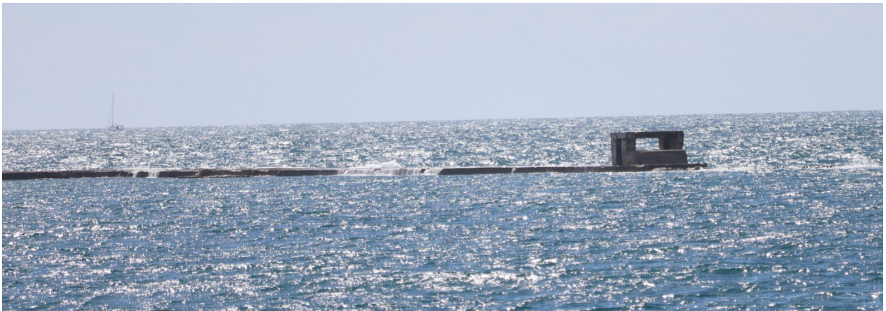
Slika 20: Vidljivo prelijevanje preko postojećeg lukobrana za vrijeme puhanja slabog do umjerenog vjetra jugozapadnog smjera (Garbina)
