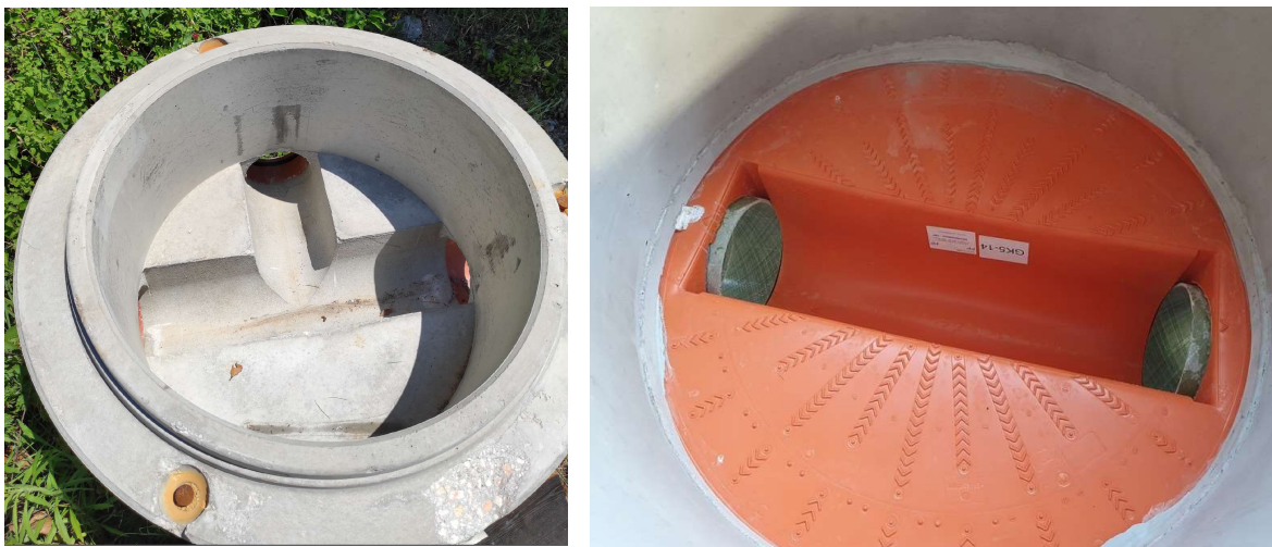
Slika 29: Primjer betonske kinete i plastičnog umetaka (autor, 2024), [12]
