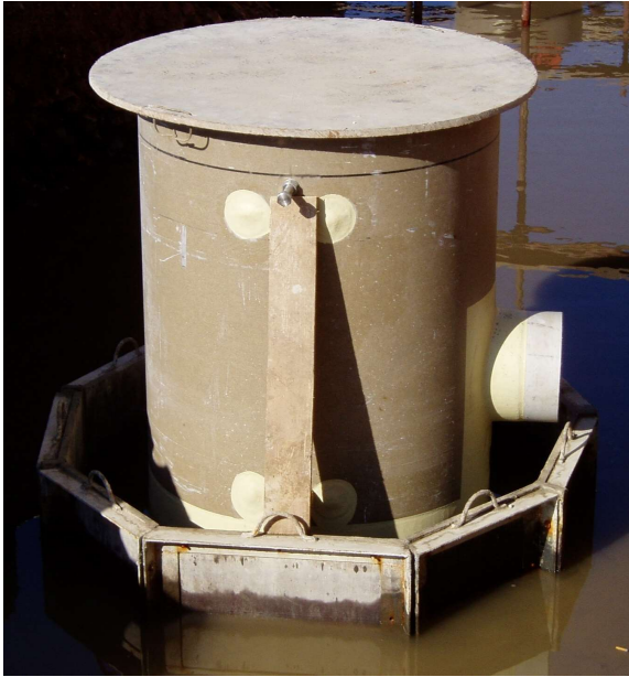
Slika 43: Primjer osmerokutnog betonskog opteživača izvedenog na licu mjesta [15]
