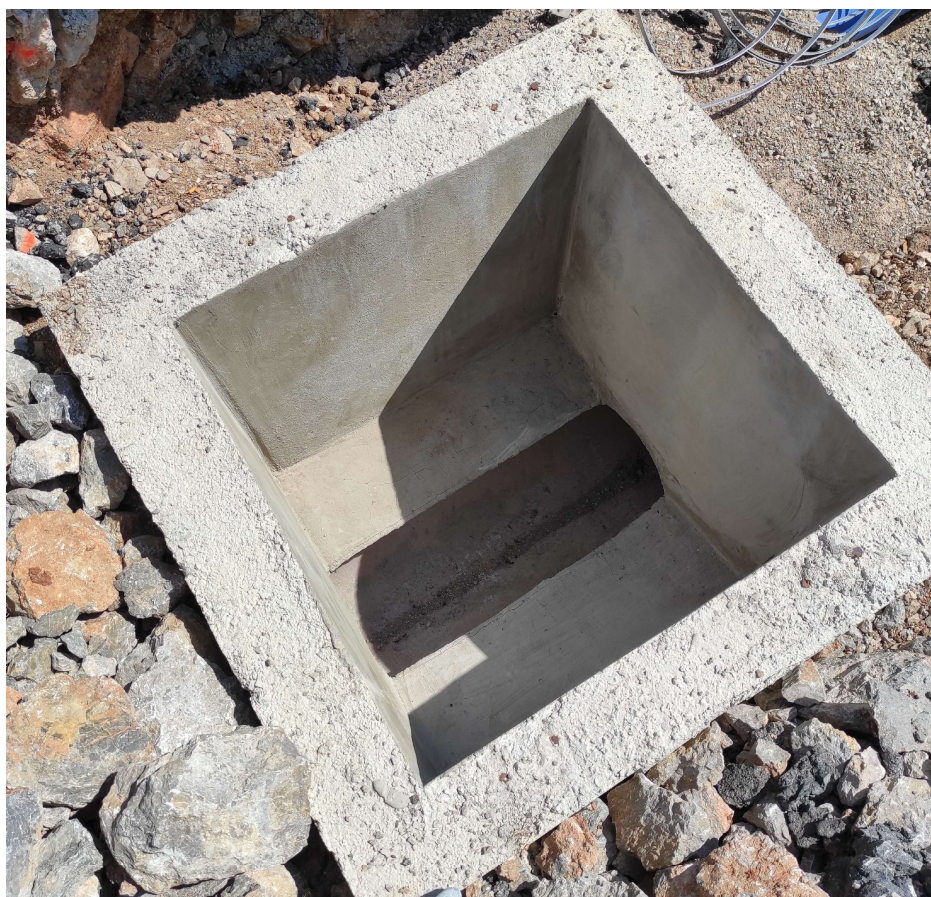
Slika 27: Obradena kineta i zidovi armirano-betonskog okna (autor, 2024)
