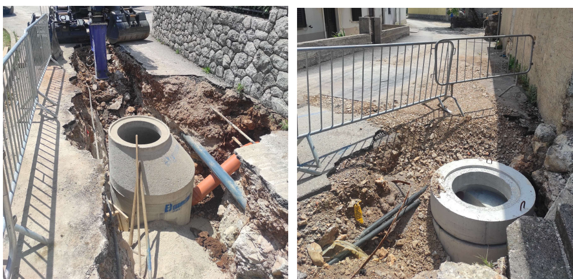
Slika 30: Primjer ugradnje predgotovljenog betonskog okna (autor, 2024)
