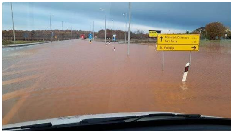
Slika 9. Poplavljena cesta pred ulazom u naselje Stancija Vodopija [9]
