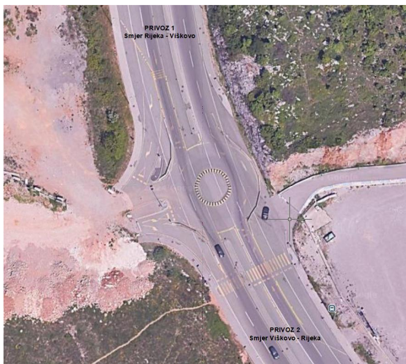
Slika 7. Postojeće stanje raskrižja na ŽC 5215 (raskrižje A)
