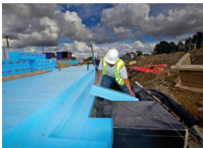
Slika 13. Postavljanje izolacije ispod podne ploče [9]
