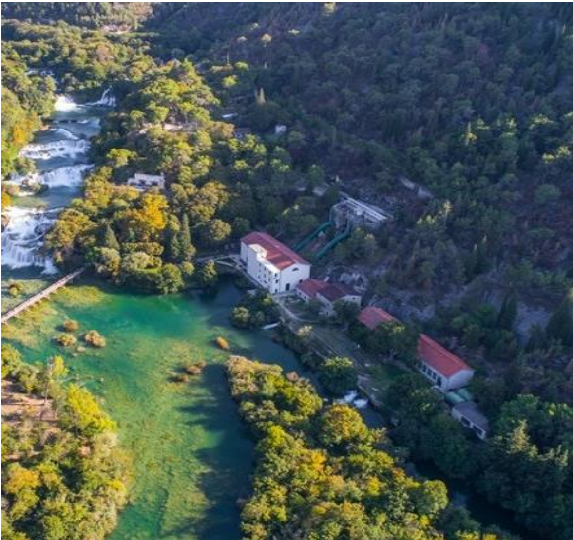
Slika 4: Hidroelektrane Jaruga I i II iz zraka [4]
