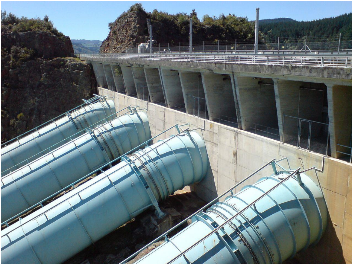
Slika 11: Tlačni cjevovod [4]
