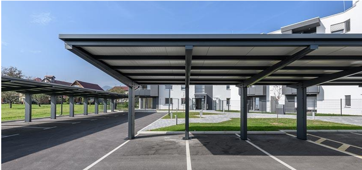
Slika 1: Konzolna metalna nadstrešnica [4]
