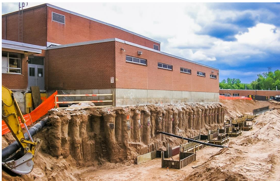
Slika 17: Izgled underpinninga [4]
