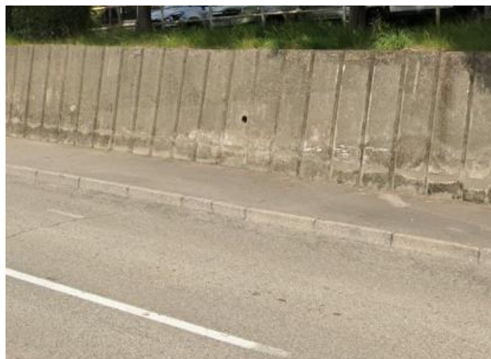
Slika 4. Primjer betonskog potpornog zida [foto-autor]
