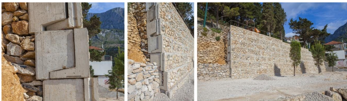
Slika 11. Primjer izvedenog montažnog zida. [Izvor: Alto Krvavica – Potporni montažni zid]
