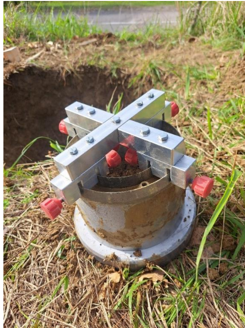
Slika 17. Ispunjeni kalup sa postavljenim držačem okvira
