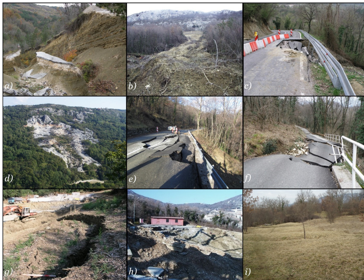
Slika 3.12 Klizišta i odroni na području istraživanja: a) translacijsko klizište Brus, b) tok zemljanog materijala Krbavčići, c) odron Marinci u sjeveroistočnoj Istri, d) klizište Grohovo, e) odron na Grohovskoj cesti, f) reaktivirano klizište iznad akumulacije Valići u dolini Rječine, g) klizište Draga u Draškoj dolini, h) klizište kraj Pomorske škole u Bakru u Bakarskom zaljevu, i) staro umireno klizište u Vinodolskoj dolini
