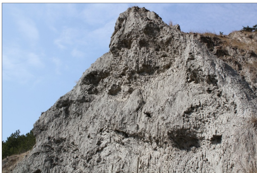
Slika 26. Fenomen eflorescencije na području žarišta erozije na slivu Slanog potoka; autor fotografije: Ivana Sušan
