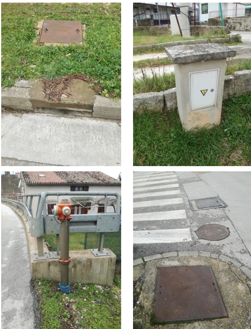
Slika br.28: Komunalna infrastruktura na lokaciji "Pragrande" Fotografirao Zuljan Beni
