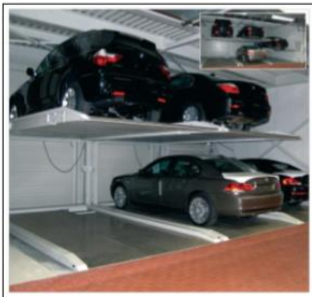
Slika br.17: Djelomično mehanizirana parking garaža Brčić, Šoštarić, 2012., str. 82
