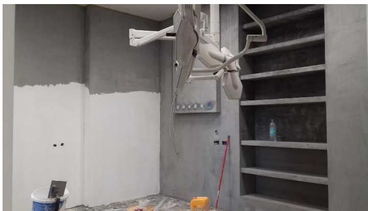
Slika 40: Operacijska sala – sloj ljepila te glet mase [Izvor: autor]
