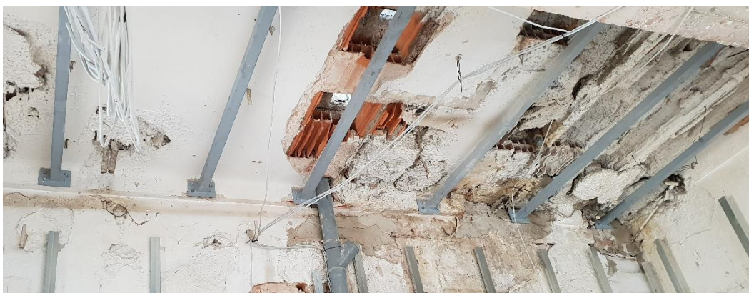
Slika 13: Izvedba čeličnog ojačanja međukatne konstrukcije s detaljem spoja na postojeće zidove. [ Izvor : autor ]
