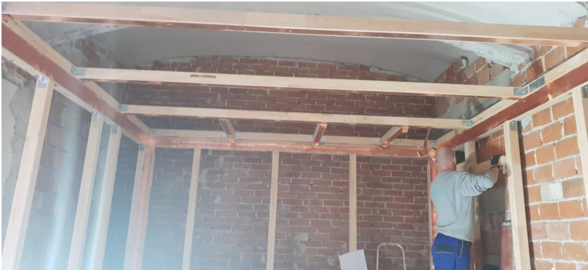
Slika 50: Izvođenje radova na konstrukciji zaštitnog kaveza magnetske rezonance [Izvor: autor]
