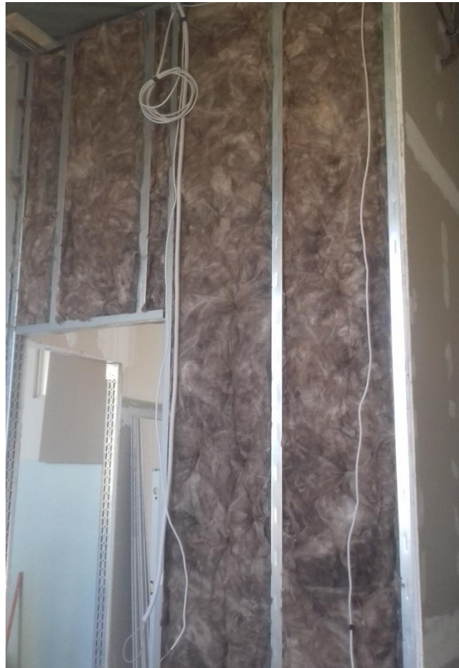
Slika 17: Postavljanje izolacijeke kamene vune između profila gipskartonskog zida [ Izvor: autor ]
