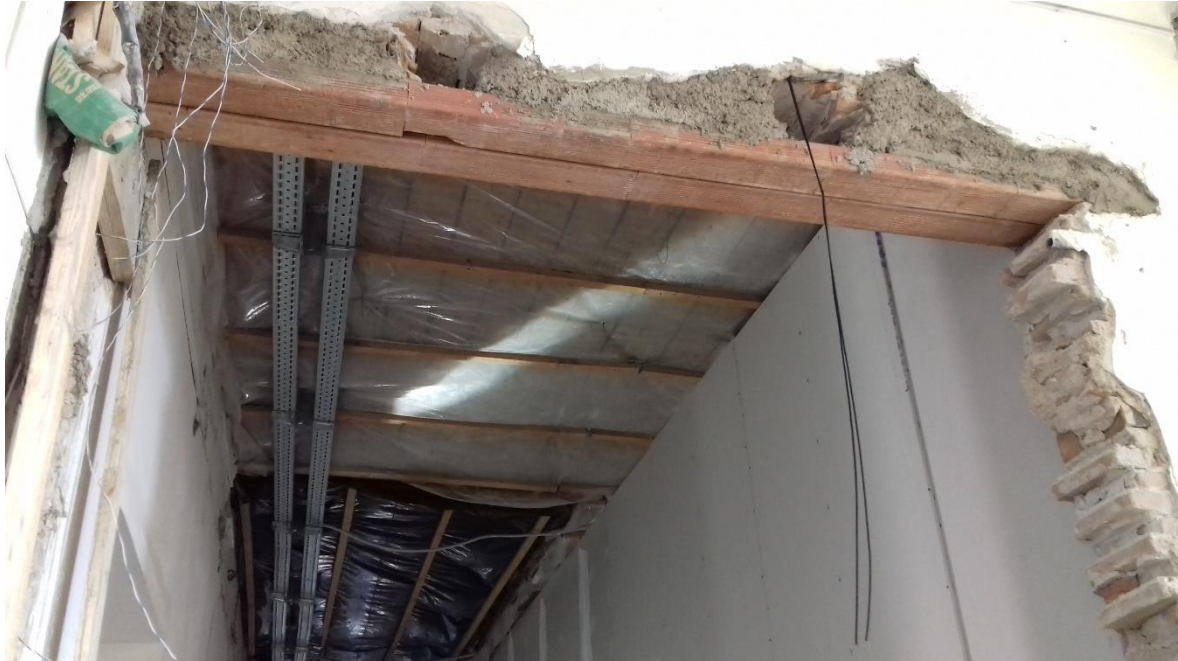
Slika 31: izrada nadvoja za otvor u zidu debljine 25 cm [ Izvor: autor ]
