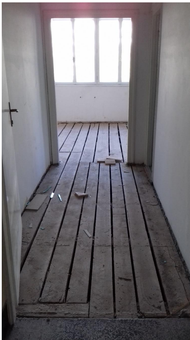
Slika 32: Skidanje slojeva poda do nosive drvene konstrukcije [ Izvor: autor]
