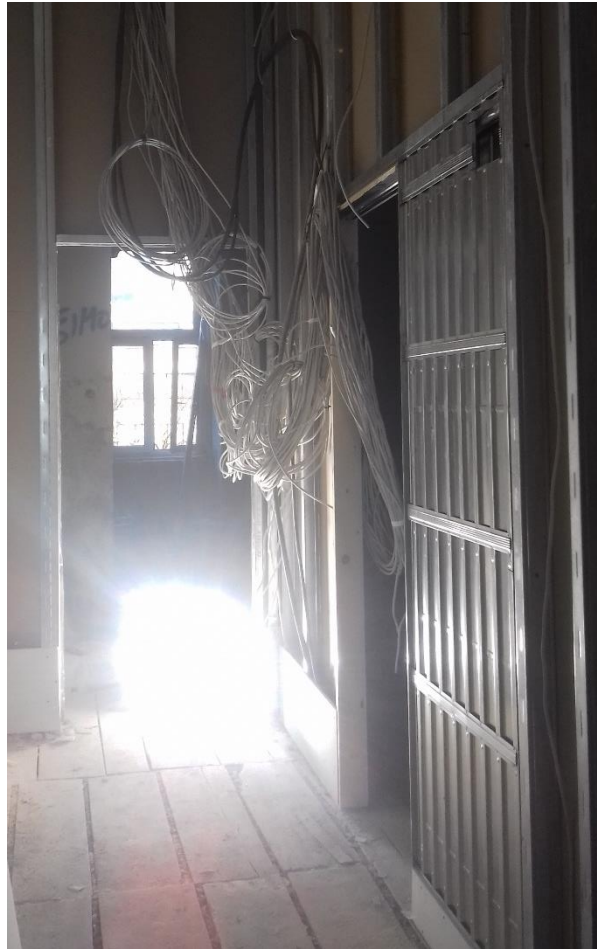
Slika 33: Kutija za prihvat kliznih vrata koja se ugrađuje u gipskartonski zid [ Izvor: autor]
