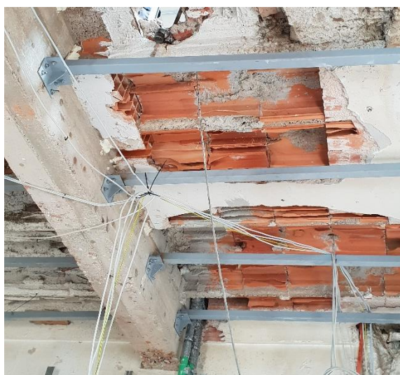
Slika 14: Izvedba čeličnog ojačanja međukatne konstrukcije s detaljem spoja na novu AB gredu [ Izvor: autor ]
