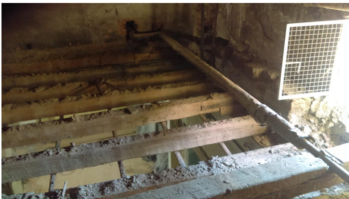
Slika 27: Postojeće grede međukatne konstrukcije [ Izvor: autor]
