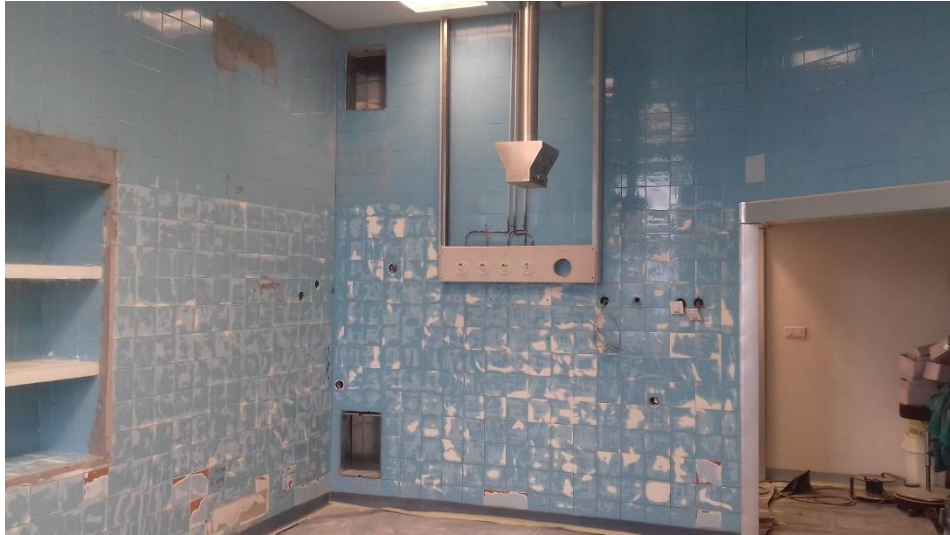
Slika 38: operacijska sala gdje se vide svi skinuti elementi te obrušena keramika [Izvor: autor]
