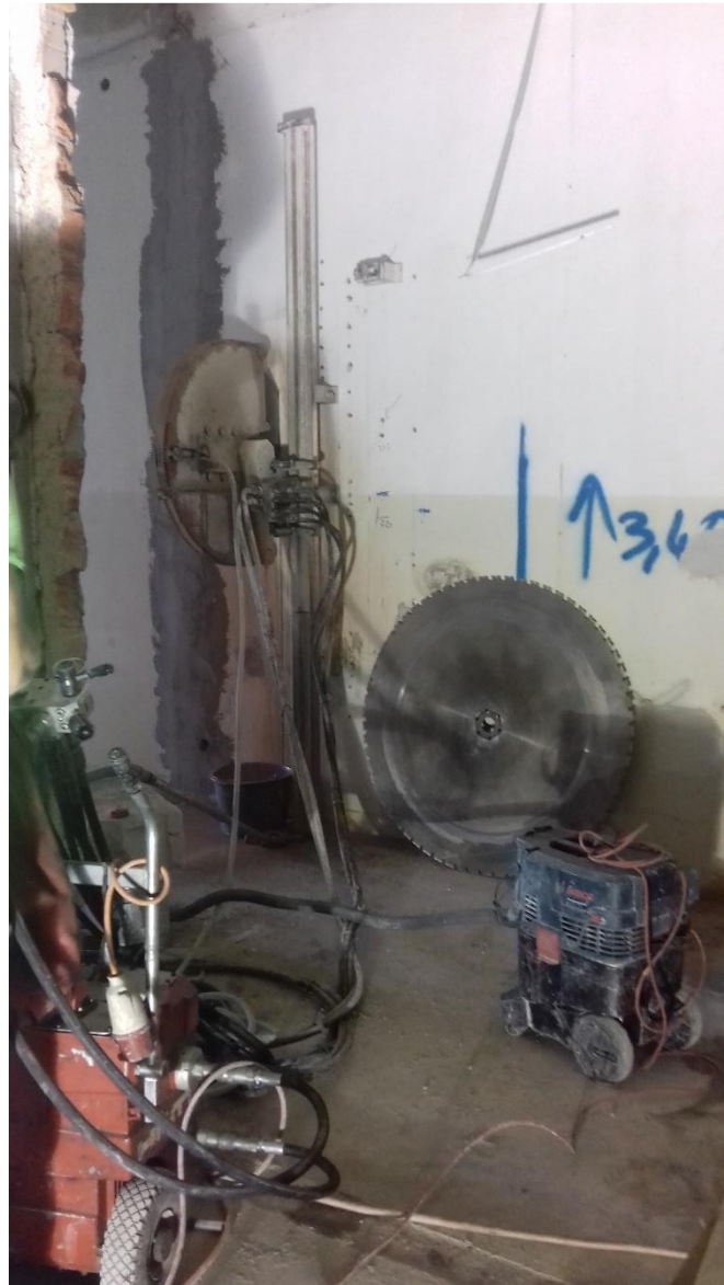
Slika 29: strojno rezanje kamenih zidova [ Izvor: autor]
