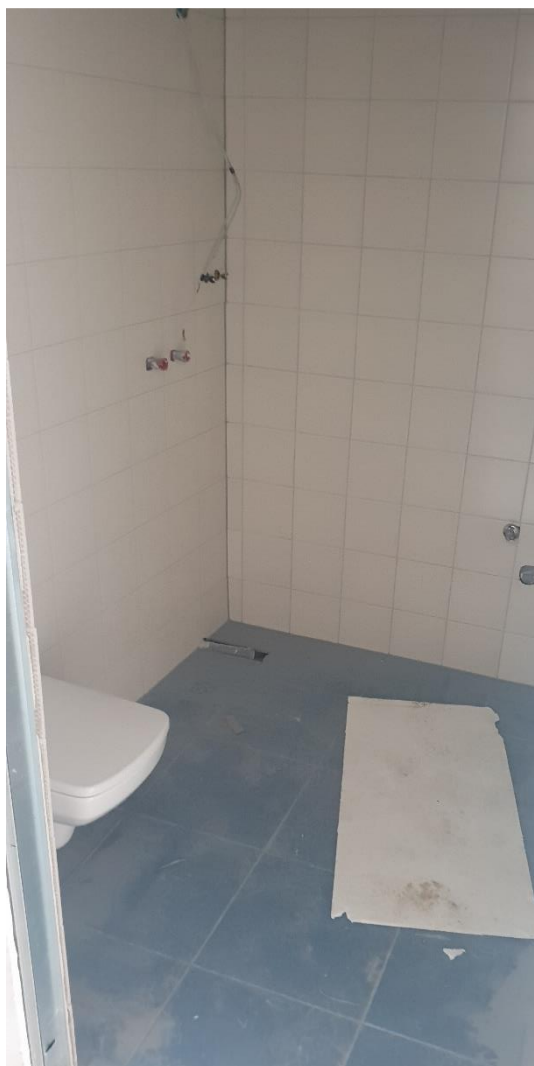
Slika 20: Izvedena podna i zidna keramika u sanitarnom prostoru, prije ugradnje sanitarnih elemenata. [ Izvor: autor ]
