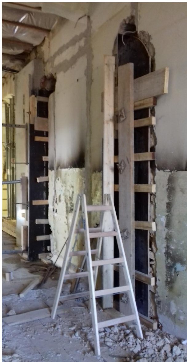
Slika 30: Izrada vertikalnih serklaža novog otvora [ Izvor: autor]
