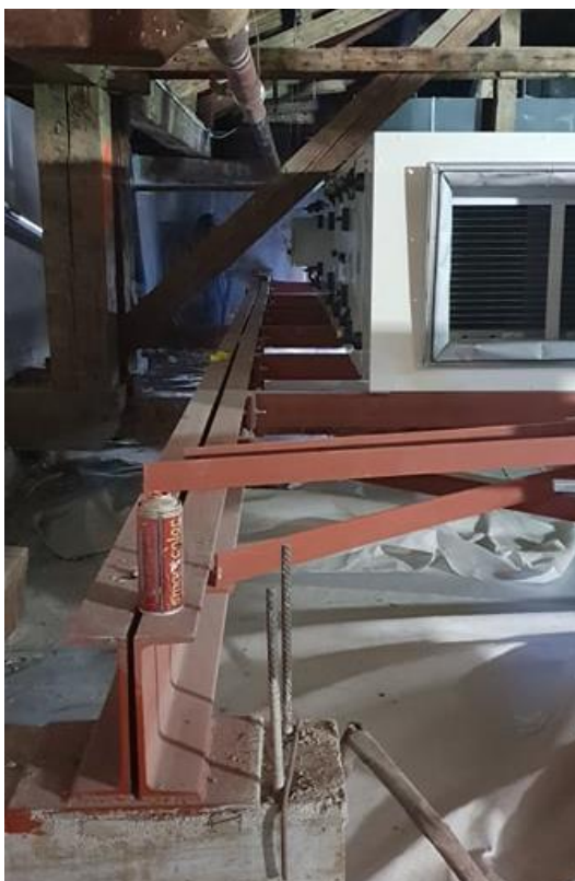
Slika 43: Čelični nosač na betonskom postolju [Izvor: autor]
