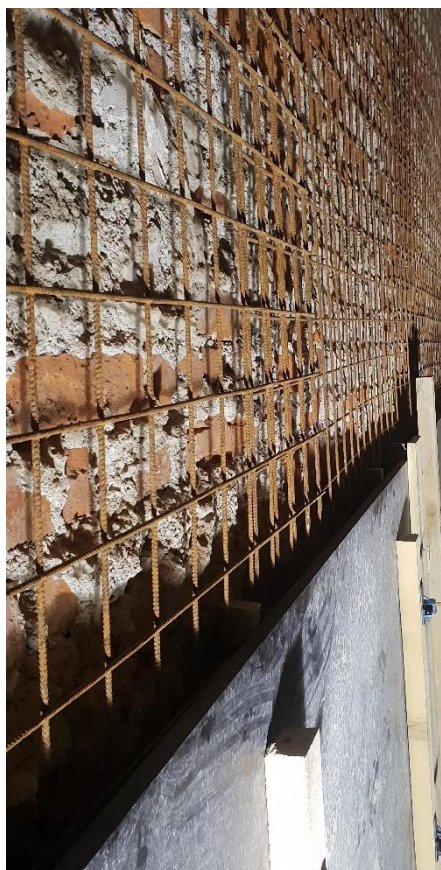
Slika 12: Izrada oplate te postavljena armaturna mreža za ojačanje postojećeg ciglenog zida [ Izvor : autor ]
