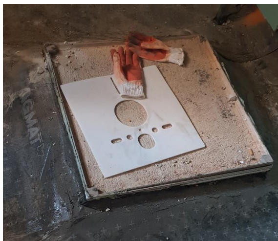
Slika 19: Šahta prizemlja s postavljenim poklopcem i hidroizolacijom do čeličnog okvira šahte. [ Izvor: autor]
