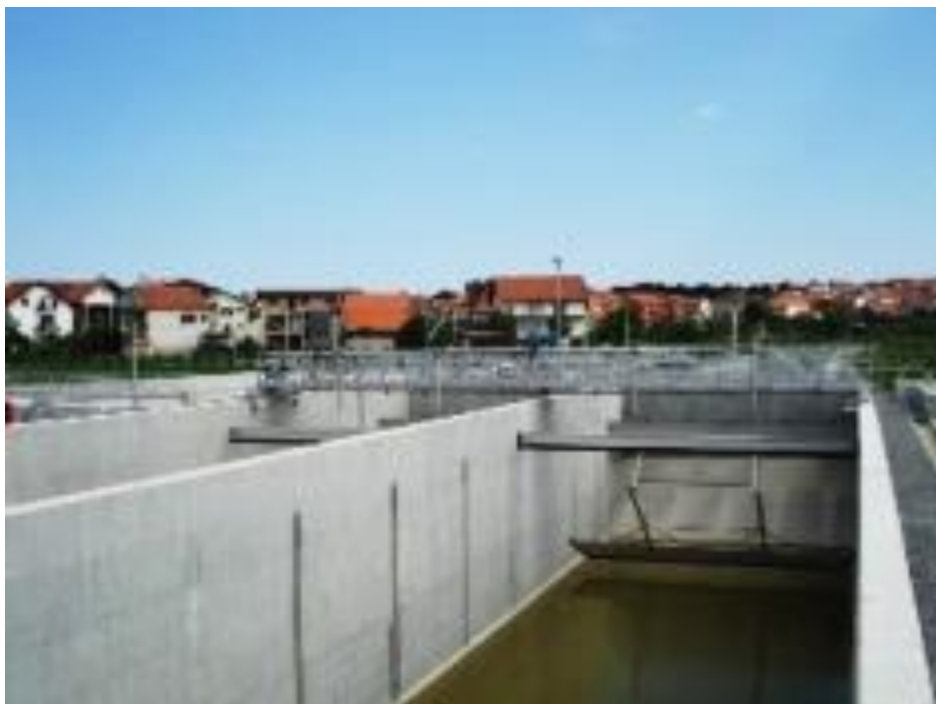
Slika 13: Primarni taložnik [1]
