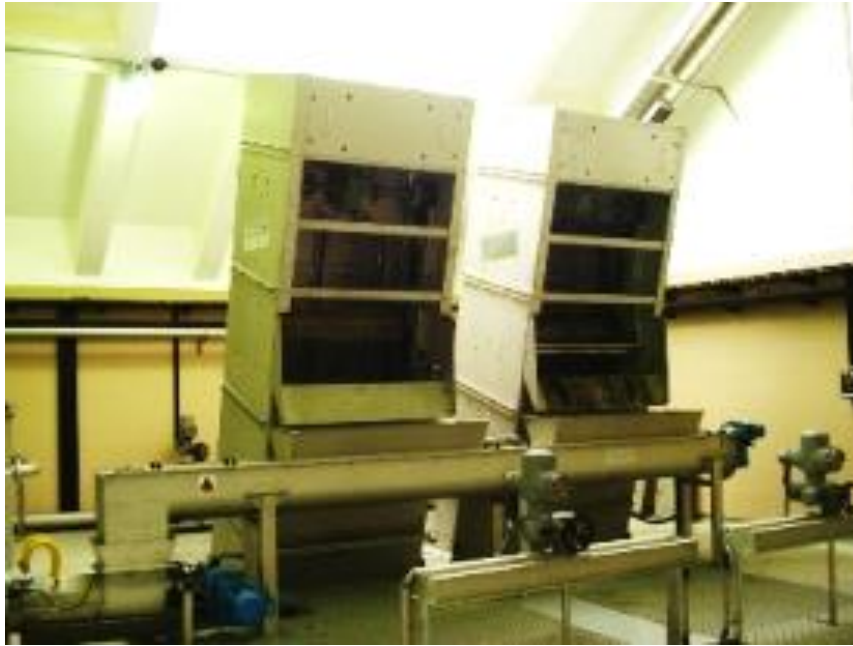
Slika 10: Grube rešetke [1]
