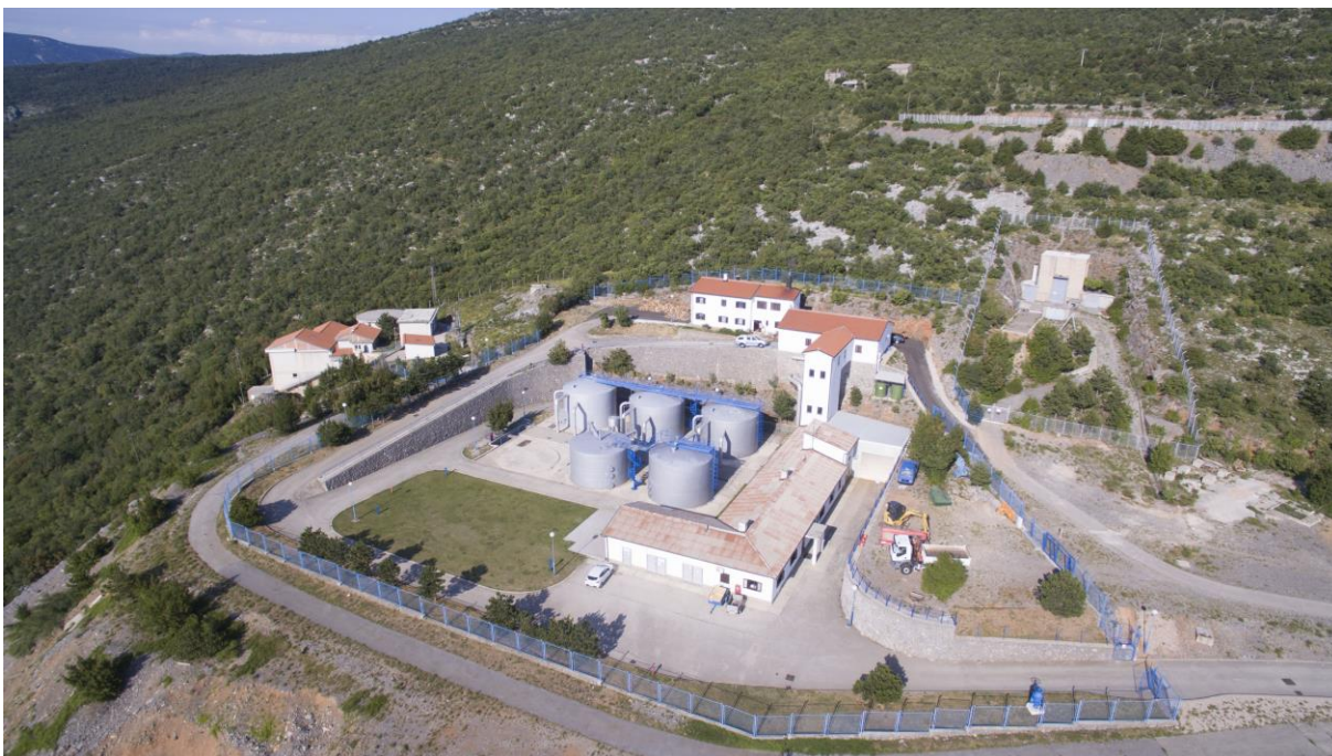
Slika 24. Uređaj za kondicioniranje sirove vode Hrmatine (Rac, 2019.)
