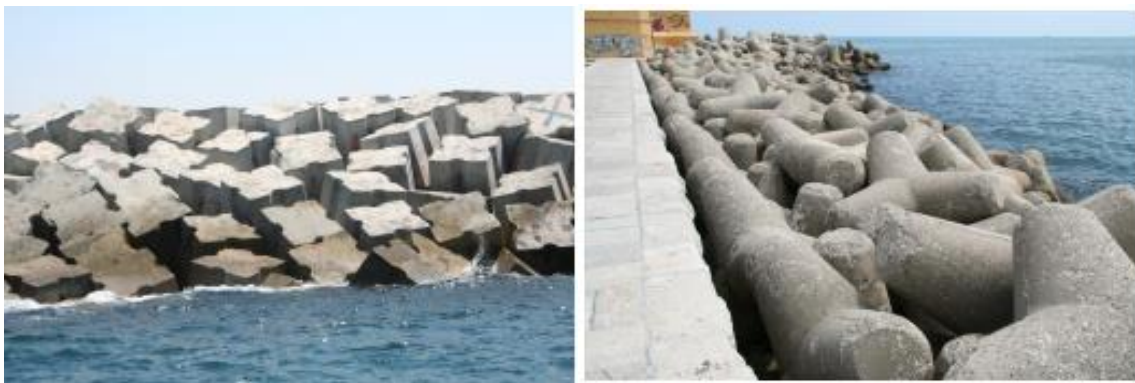
Slika 9: Lukobran obložen antiferima (lijevo) i tetrapodima (desno) [1]
