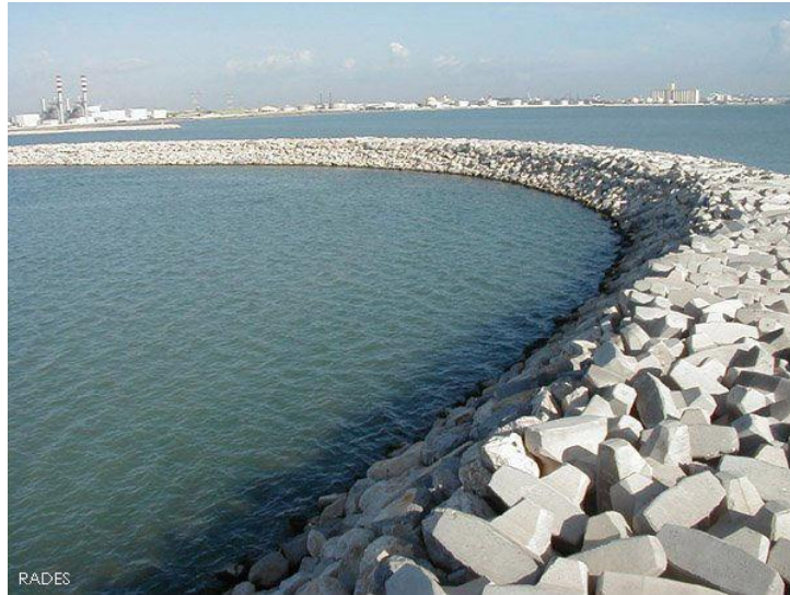
Slika 7: Nasuti lukobran od predgotovljenih betonskih elemenata [9]
