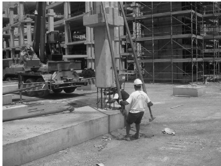
Slika 22: Spoj stup-temelj izveden injektiranjem prethodno izvedenih kanala [2]
