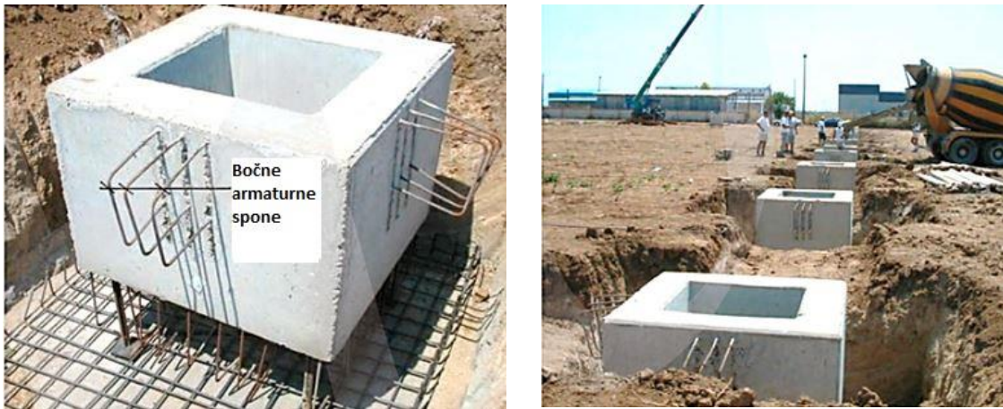
a) Slika 3: Čašica s bočnim armaturnim sponama za spoj s veznim gredama a) prije betoniranja temeljne stope, b) nakon betoniranja temeljne stope [8]
