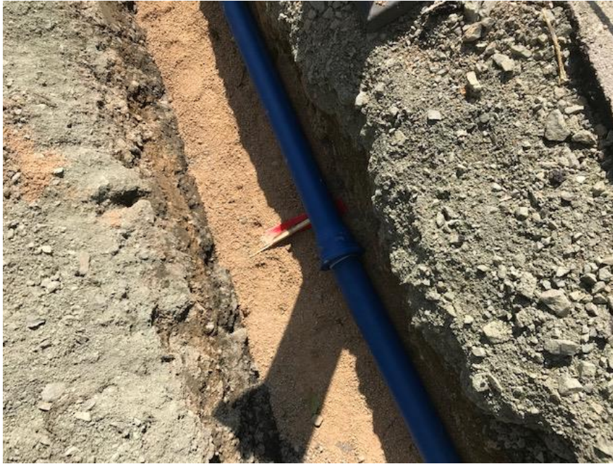
Slika 6: Pješčana posteljica na kojoj je postavljena cijev
