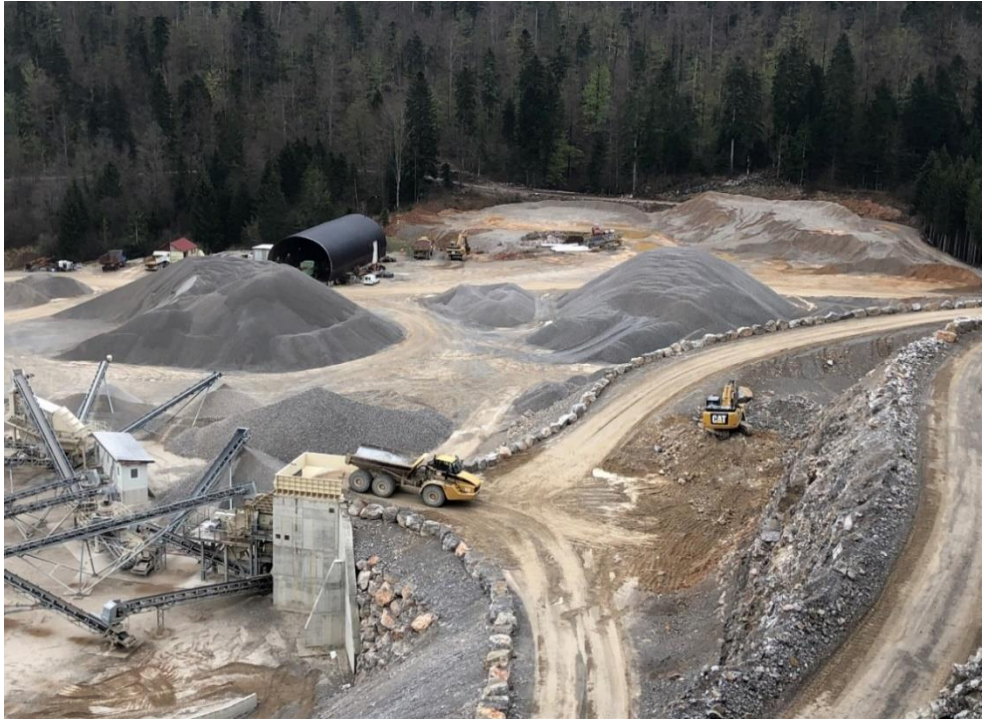
Slika 16: Doprema kamena do drobilice
