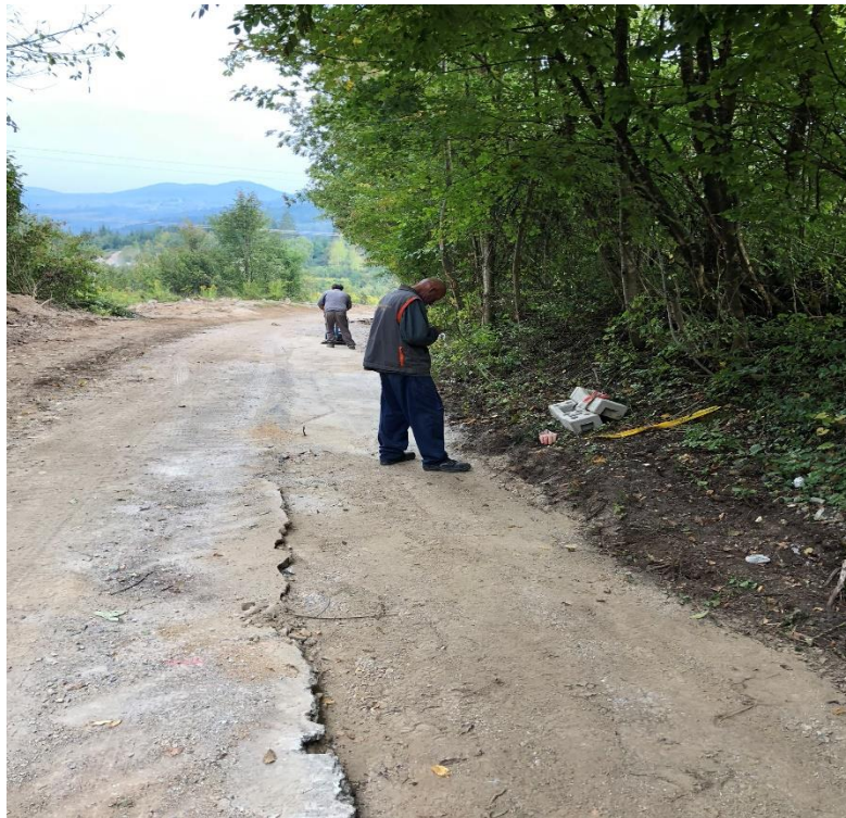
Slika 10: Ugradnja tampona u rov
