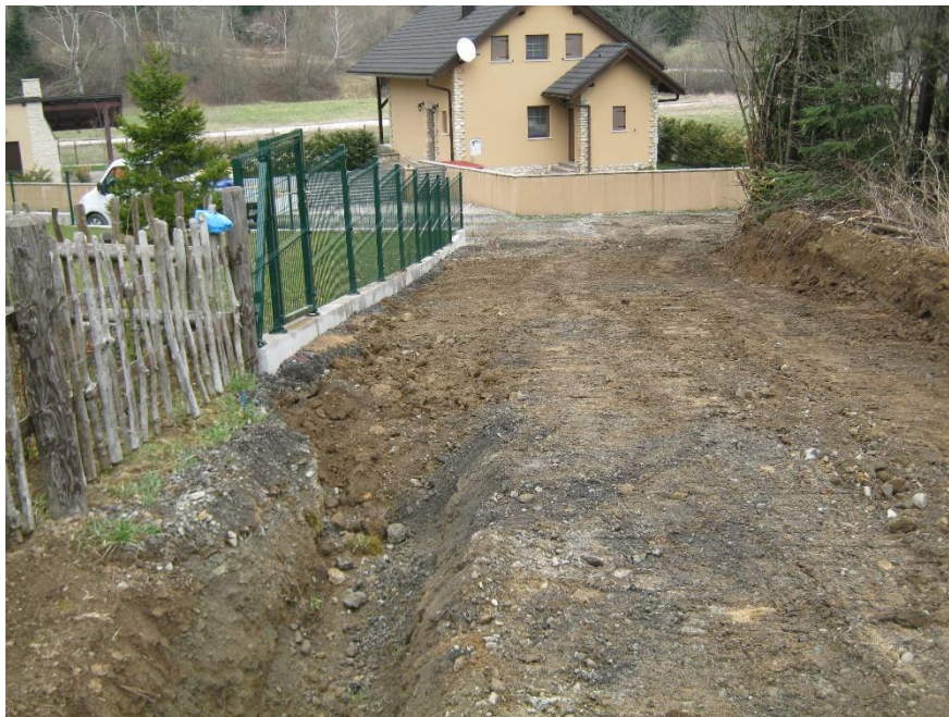
Slika 12: Obnova tucaničkog kolnika kamenim materijalom
