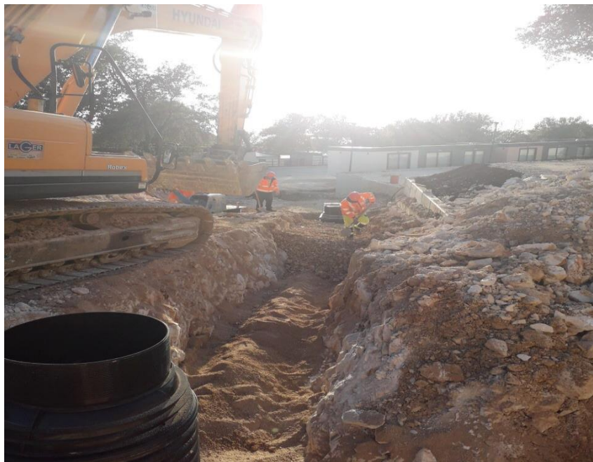
Slika 8: Zatrpavanje rova pijeskom
