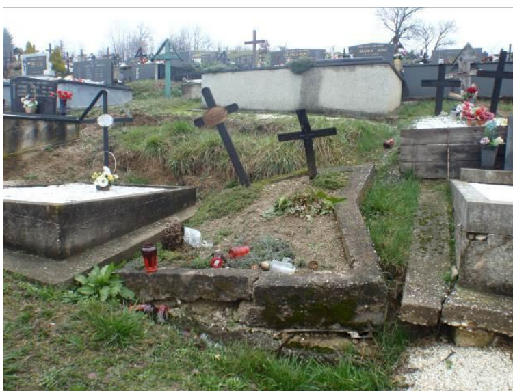
Slika 23. Oštećenja na grobovima (preuzeto iz Mihalić Arbanas i dr., 2014).
