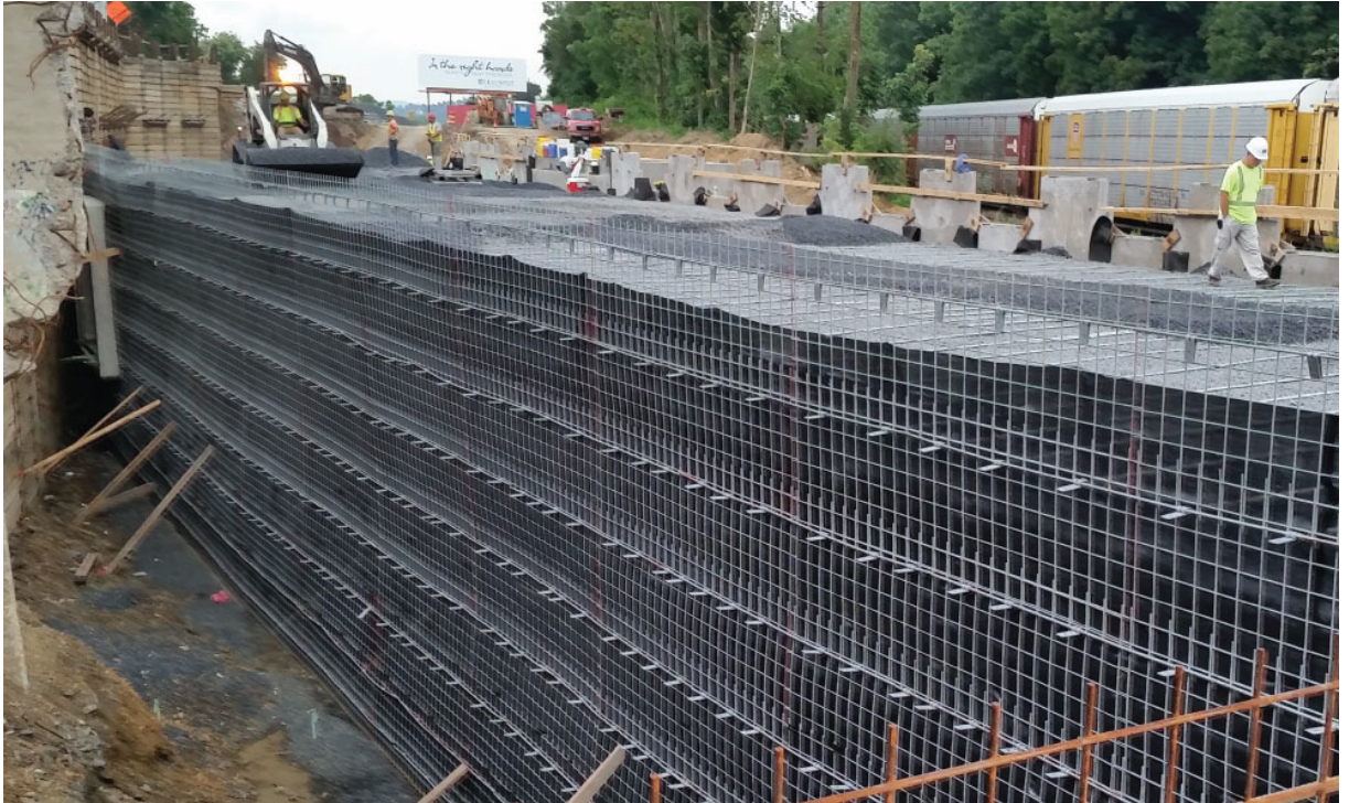
Slika 9. Fazna gradnja ceste ( https://reinforcedearth.com )
