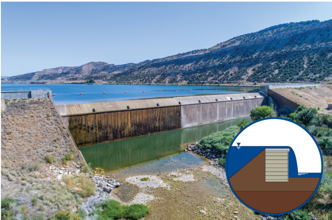
Slika 16. Preljevni zid ( https://reinforcedearth.com )
