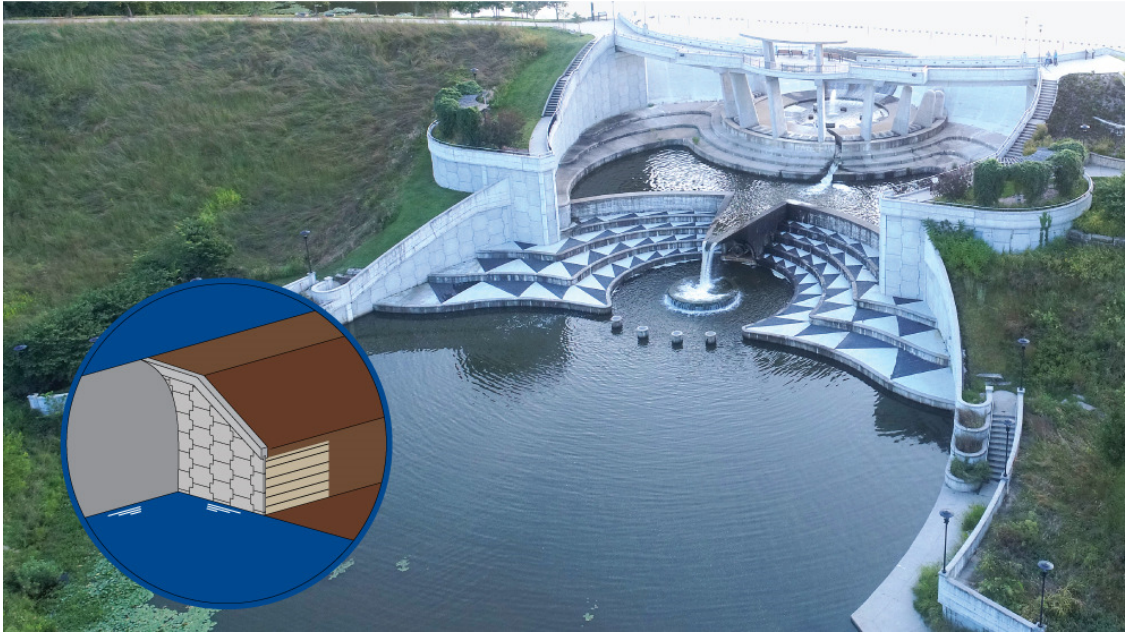
Slika 17. Zid preljeva ( https://reinforcedearth.com )
