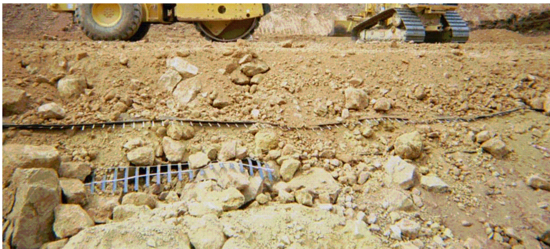
Slika 47. Armirano tlo bez lica (Roje-Bonacci, 2005.)
