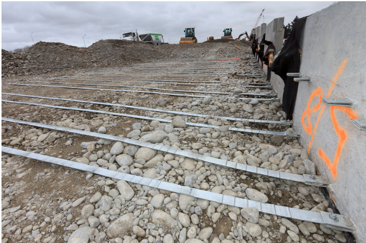
Slika 28. Metalne trake od galvaniziranog čelika ( https://www.tensar.com.hr )
