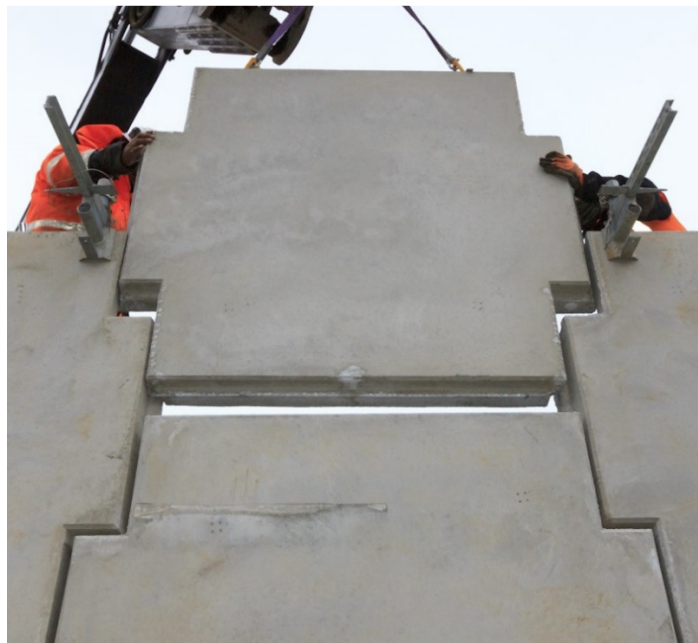
Slika 76. Postavljanje panela( http://www.trulinecivil.com )
