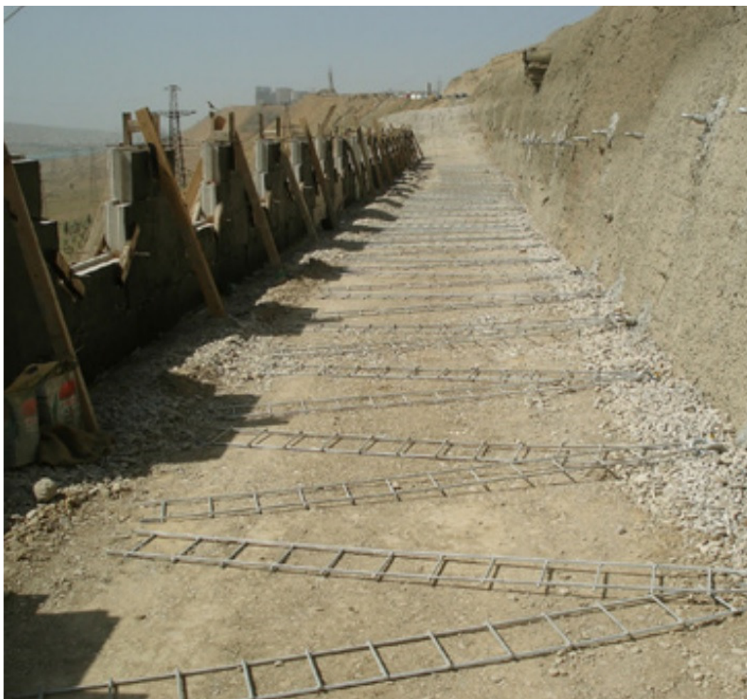
Slika 30. Čelične trake ili „ljestve“ ( https://www.tensar.com.hr )
