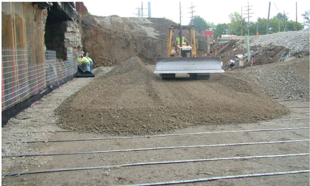
Slika 29. Zatrpavanje metalne armature ( https://www.tensar.com.hr )
