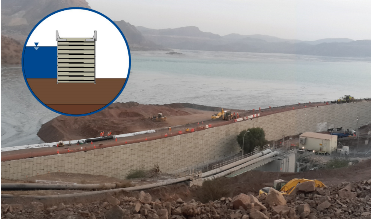
Slika 19. Zemljana brana sa dva lica ( https://reinforcedearth.com )
