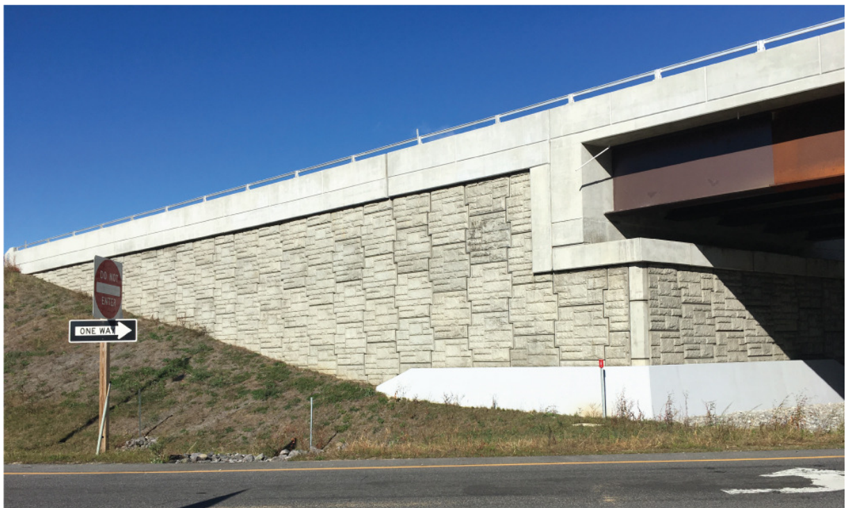
Slika 2. Primjer mehanički stabiliziranog zemljanog zida ( https://reinforcedearth.com )
