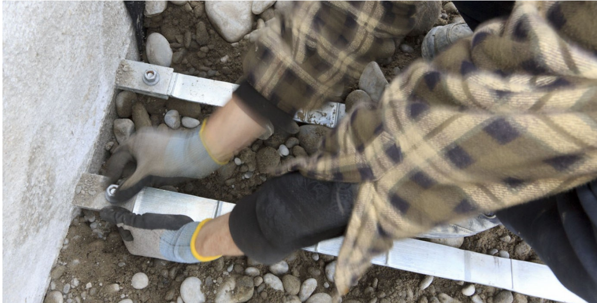
Slika 73. Postavljanje metalne armature ( http://www.trulinecivil.com )
