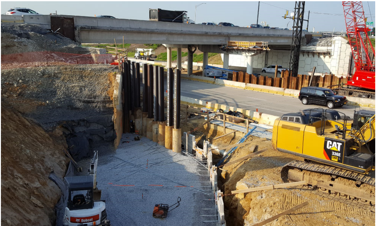
Slika 13. Proširenje mosta ( https://reinforcedearth.com )
