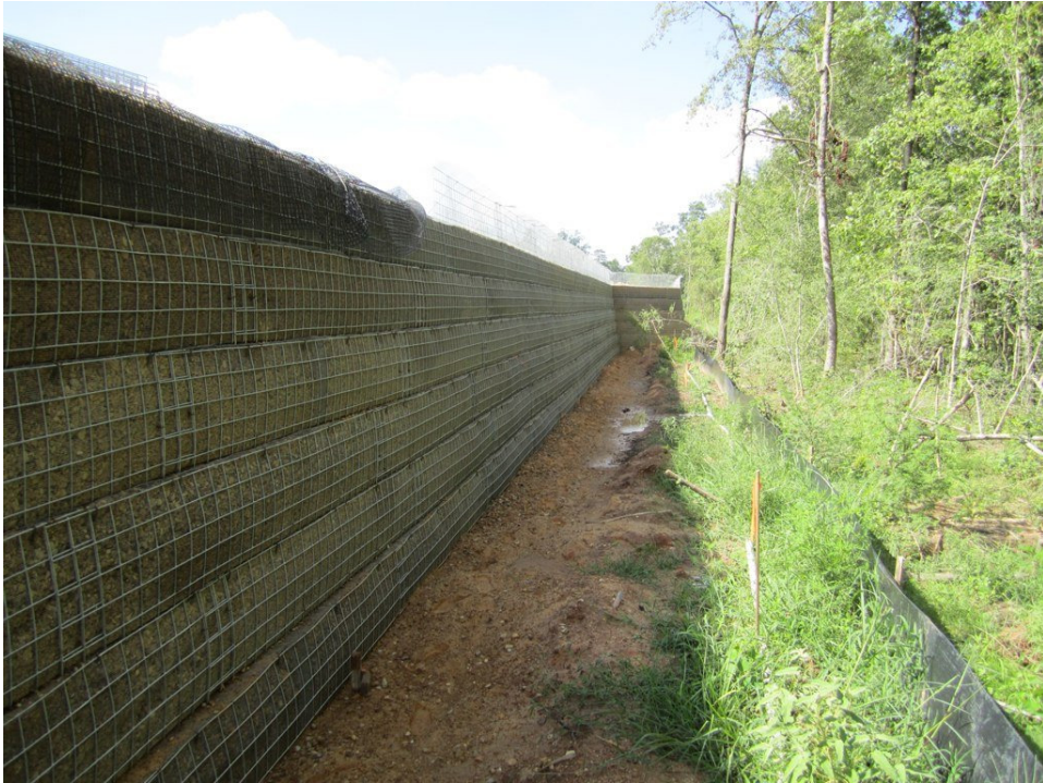
Slika 57. Lice zida od zavarene mreže ( https://bluestonesupply.com )
