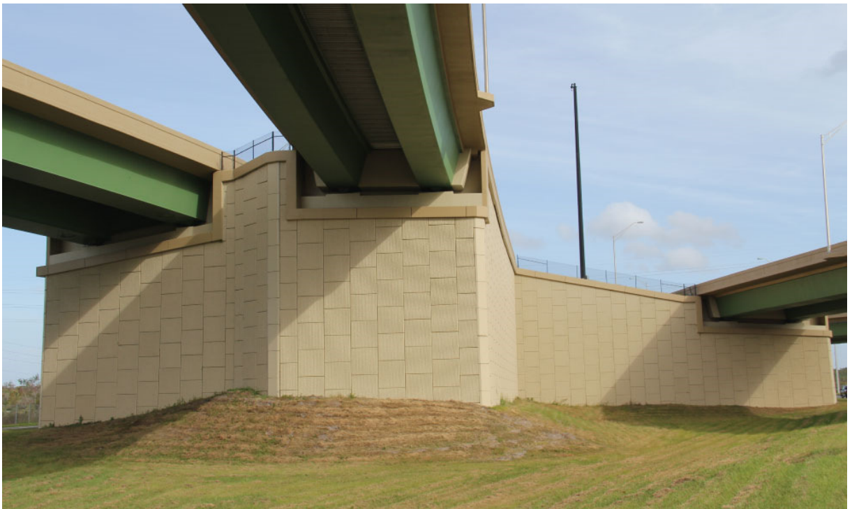
Slika 8. Upornjak mosta ( https://reinforcedearth.com )
