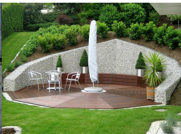
Slika 9: Gabionski potporni zid [10]
