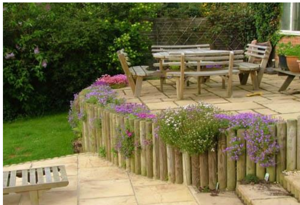
Slika 18: Potporni zid od drva [16]
