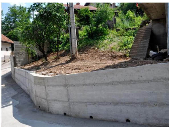
Slika 8: Armirano-betonski potporni zid [2]
