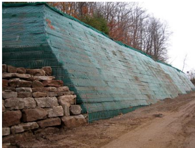
Slika 13: Zid od nasutog materijala ojačan geomrežom [13]
