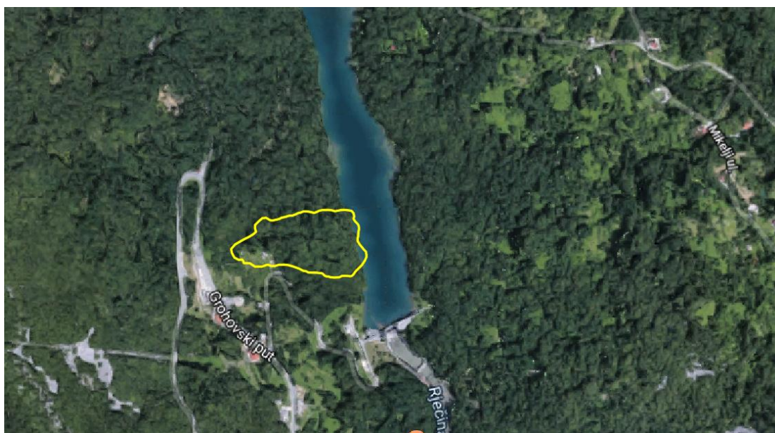
Slika 17: Položaj klizišta i akumulacije Valići [20]
