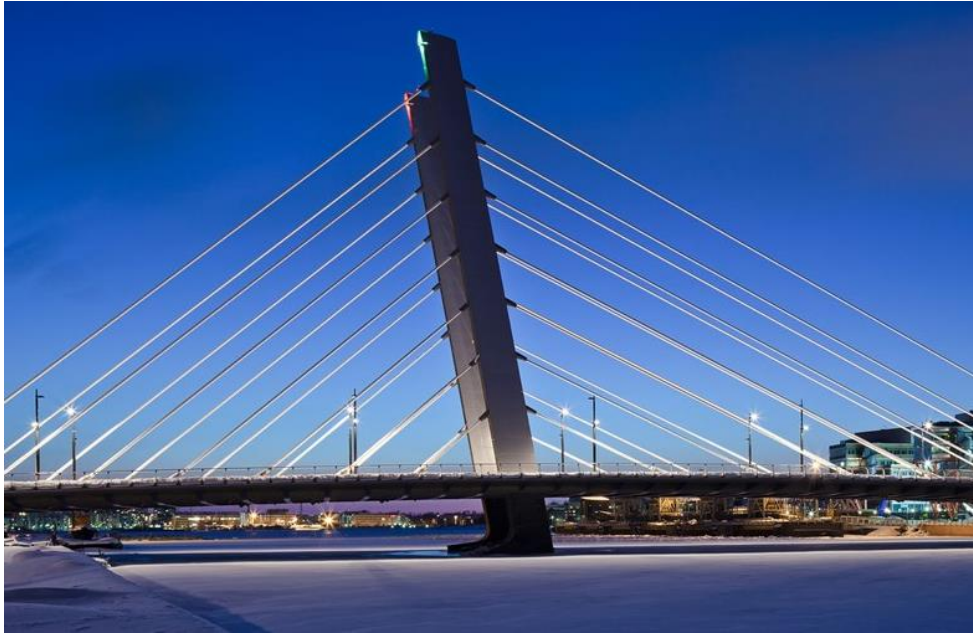
Slika 19. Crusell most, Helsinki [40]
