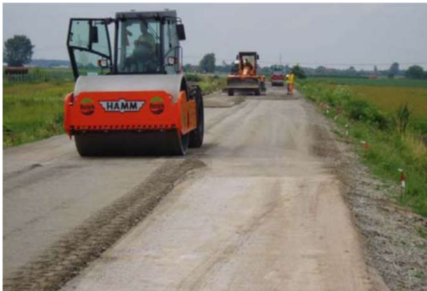
Slika 17: Faza zbijanja hladno recikliranog sloja [7]
