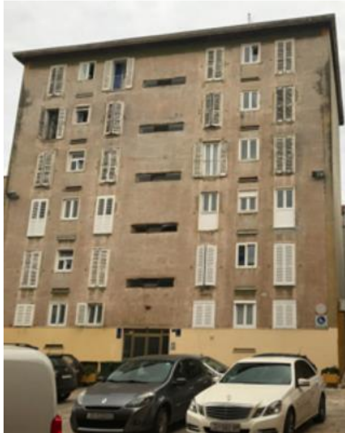
Slika 21: Pogled na zgradu ZB II prema projektu Slavka Šimatića [21]
