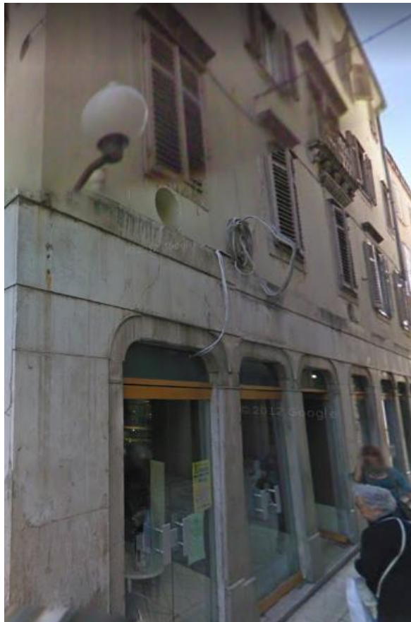
Slika 35: Pogled na zgradu u ulici braće Vranjanina 9/1 [19]
