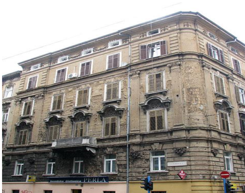
Slika 10: Sjeverno pročelje, Uglovnica Burgastaller
