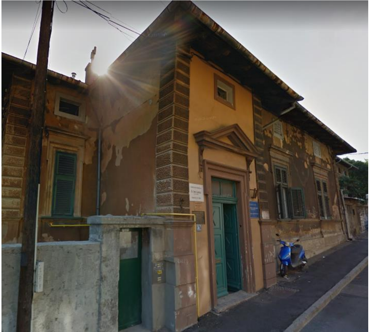
Slika 8: Sjeverno pročelje, stvarno stanje Villa Illy
