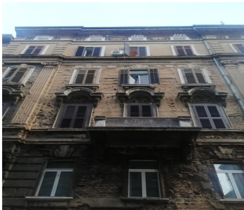
Slika 11: Sjeverno pročelje, pogled odozdo
