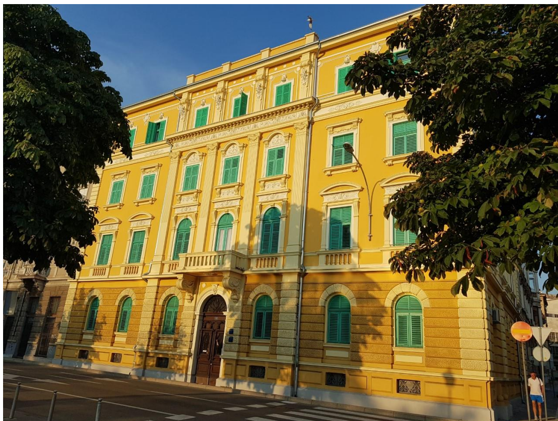
Slika 41: Obnovljena fasada zgrade u ulici Šetalište A. K. Miošića, Rijeka
