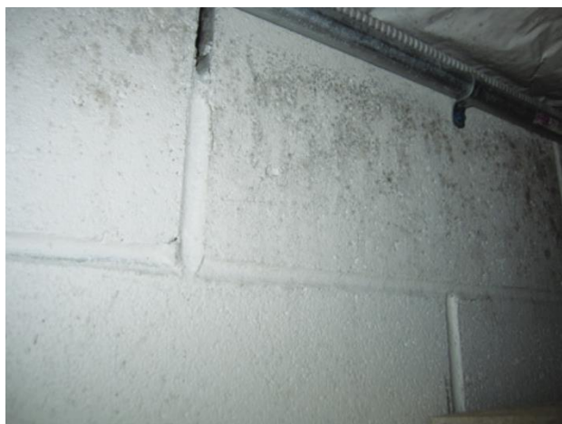
Slika 3: Rast plijesni na obojanom betonskom zidu [5]
