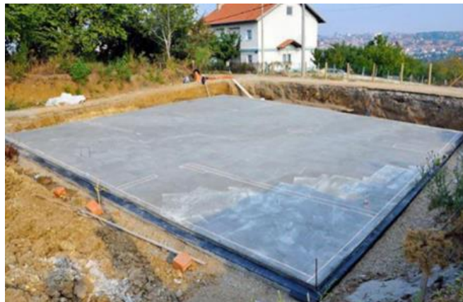
Slika 59: Horizontalna hidroizolacija [13]
