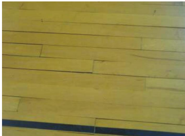
Slika 7: Iskrivljeni drveni pod [5]
