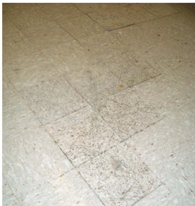
Slika 4: Rast plijesni na vinil pločicama [5]
