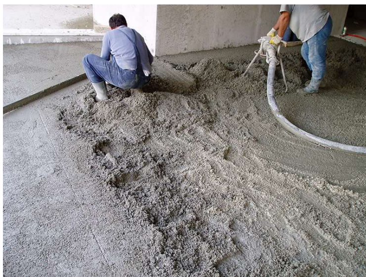
Slika 4: Izrada plivajućeg poda od EPS betona [8]
