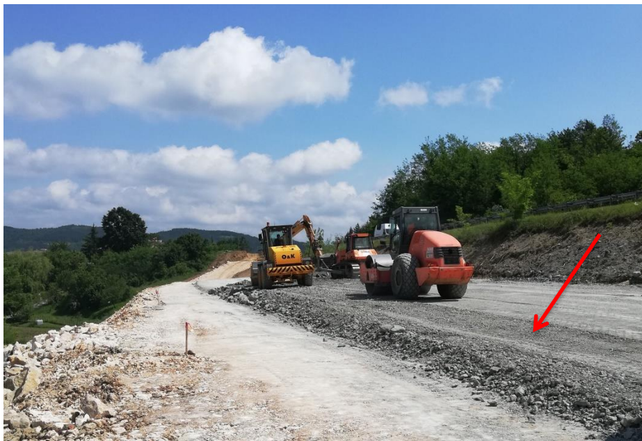
Slika 12. Svježa flišna masa kao materijal za nasip prilikom izgradnje ceste.
