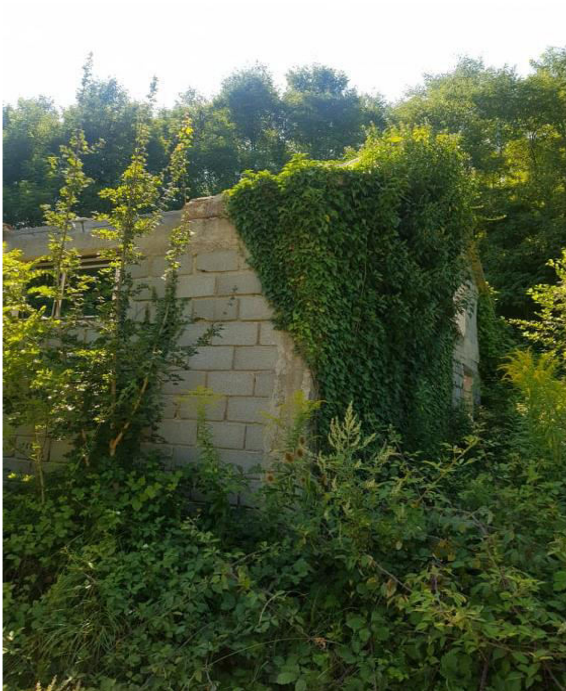
Slika 38. Napuštena građevina obrasla zelenilom prema mostu Luke u poljoprivrednom području (foto: M. Mavrinac; kolovoz 2019.)
