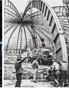
Slika 37: Postavljanje Schwedlerove kupole 1955.godine (KSi structural engineers 2014)
