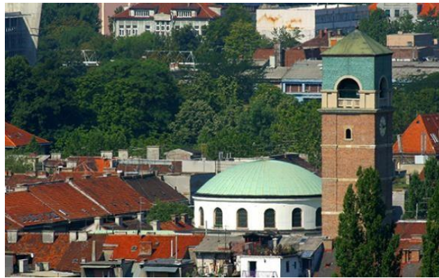
Slika 11: Prikaz armiranobetonske kupole crkve sv. Blaža u Zagrebu (Svblaz 2013)
