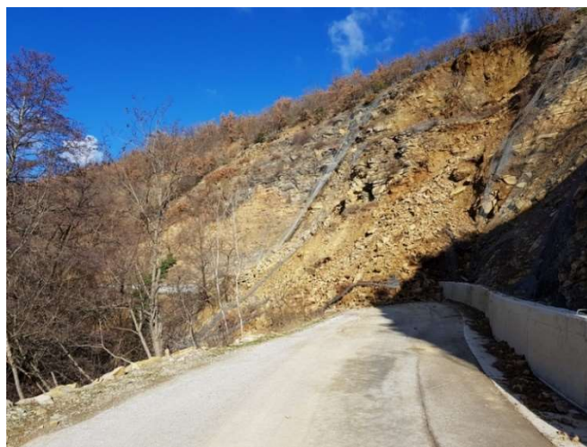
Slika 41: Odron na županijskoj cesti ŽC6034, lokacija Radljevac [36]
