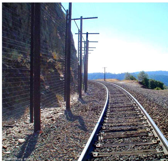
Slika 29: Ograda za detekciju odrona [19]
