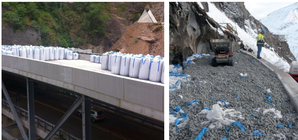
Slika 39: Apсорbirajući sloj od vreća pijeska na koje je postavljen sloj šljunka [32]
