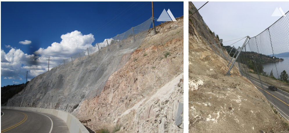
Slika 36: Viseće mreže – atenuatori [31]
