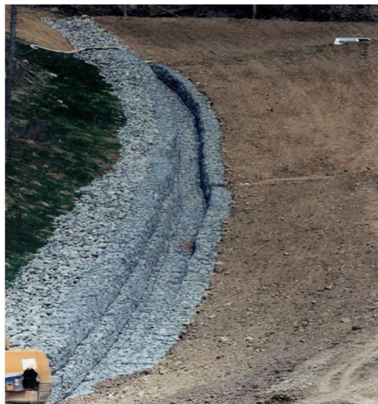
Slika 27: Jarak za hvatanje odrona [3]
