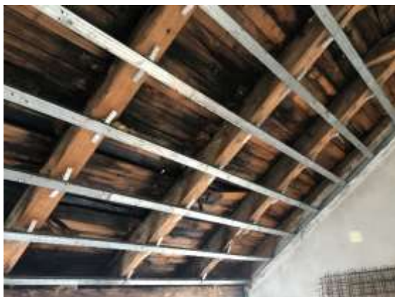
Slika 4.c: Modrina na daščanoj oplati i raspucalost
