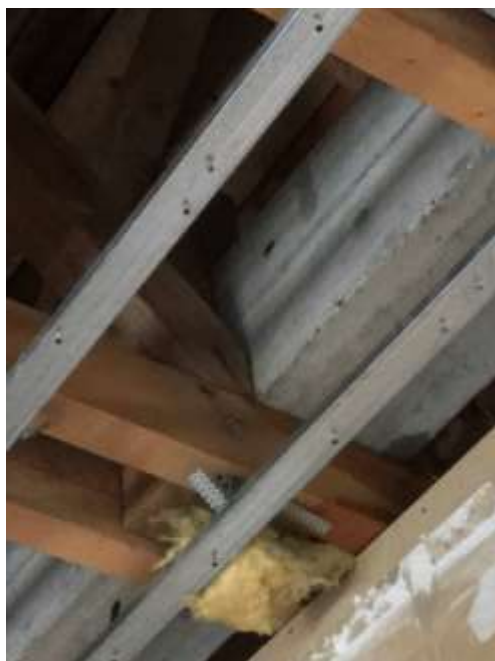
Slika 2: Spoj pajante i vertikalne kladice
