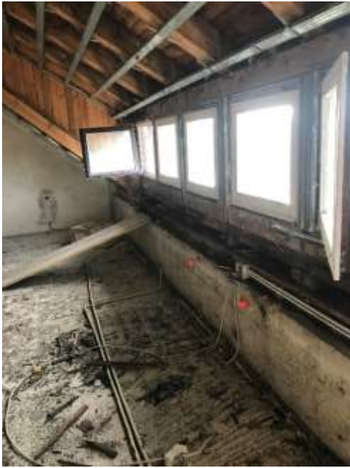
Slika 5.a i 5.b: Trula konstrukcija drvenog veznog sustava iznad masivnog nadozida na zapadnom pročelju
