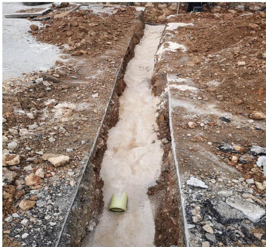
Slika 15: Zasipavanje položenih cijevi s pijeskom 0 – 4 mm
