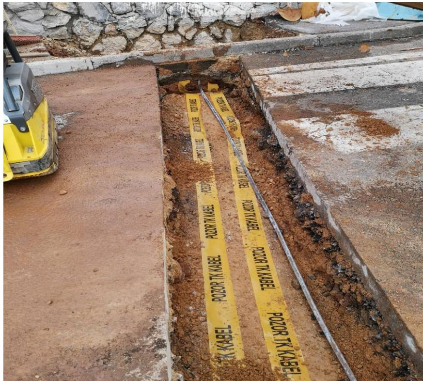
Slika 18: Zatrpavanje rova i postavljanje DTK zaštitu
