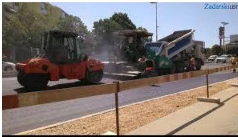
Slika 23: Ugradnja asfalta
