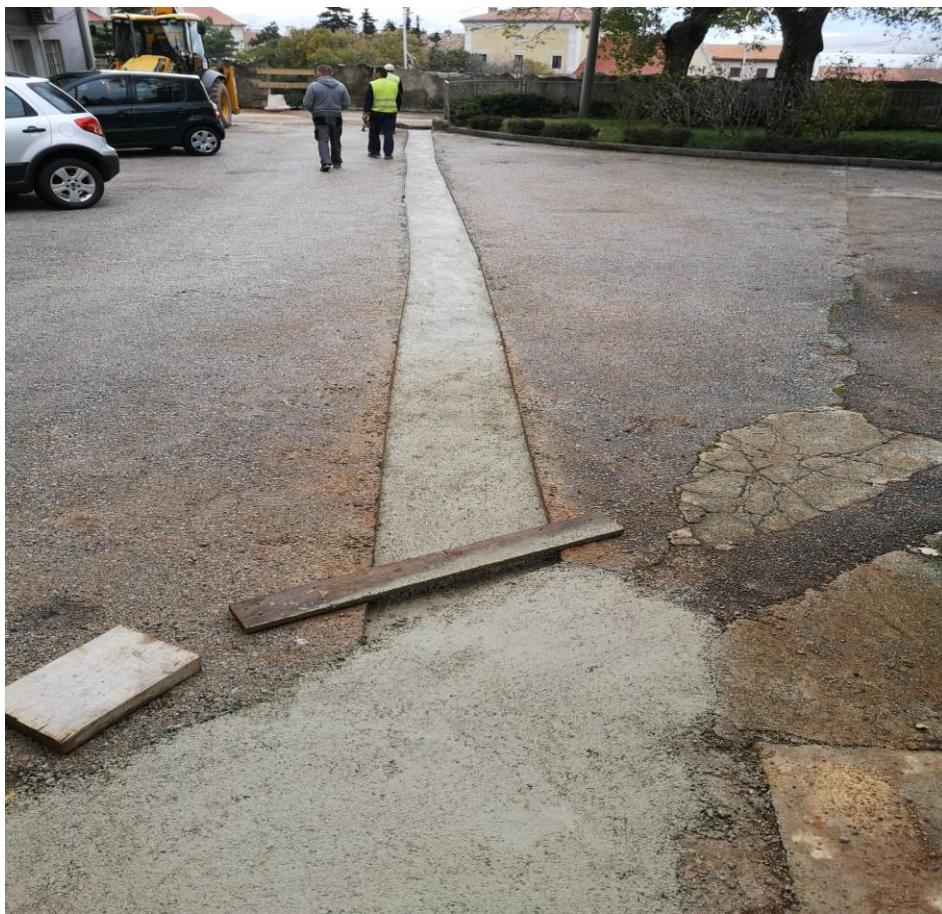
Slika 22: Izvedba betonske stabilizacije
