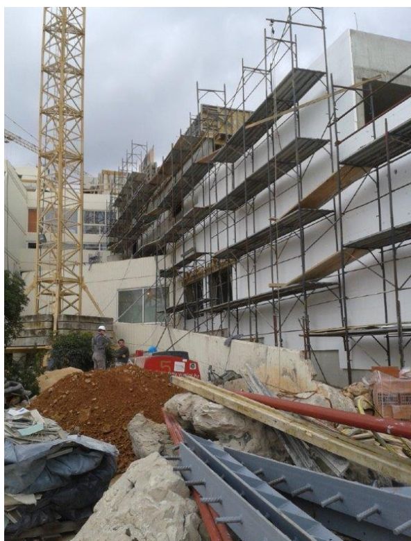
Slika 118. Postava izolacije, 2014.
