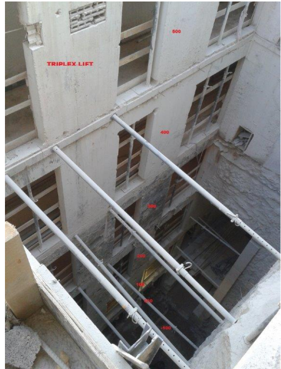
Slika 94. Iskop okna dizala, 2013.
