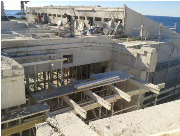
Slika 91. Rezanje betona, 2013.
