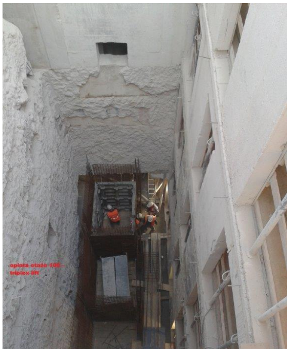
Slika 102. Betoniranje okna dizala, 2013.
