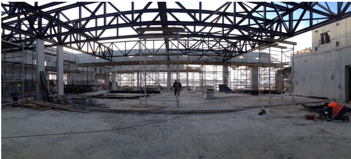
Slika 52. Izvođenje radova čeličnog krova recepcije, 2014.
