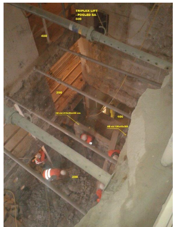
Slika 95. Podupirači pri iskopu, 2013.
