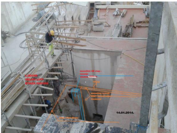
Slika 93. Rezanje betona, 2013.
