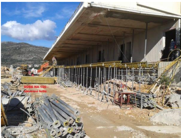
Slika 107. Priprema oplata, 2013.
