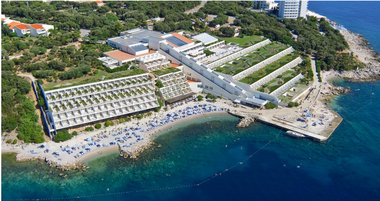
Slika 29. Snimka iz zraka postojećeg stanja prije rekonstrukcije, 2013.
