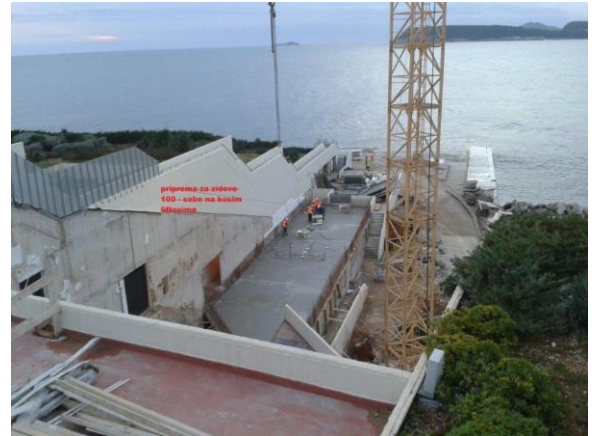
Slika 115. Betoniranje stepenastih soba, 2013.
