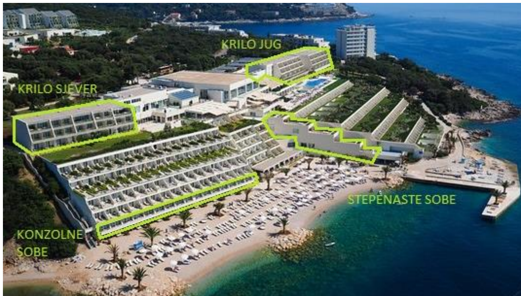
Slika 63. Prikaz dogradnje smještajnog dijela
