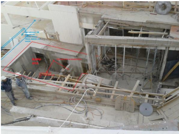
Slika 92. Rezanje betona, 2013.
