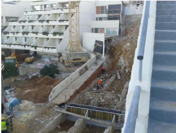
Slika 113. Betoniranje stepenastih soba, 2013.
