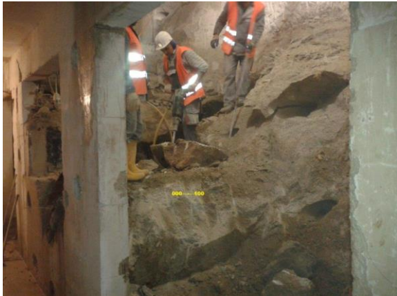
Slika 96. Iskop okna dizala, 2013.
