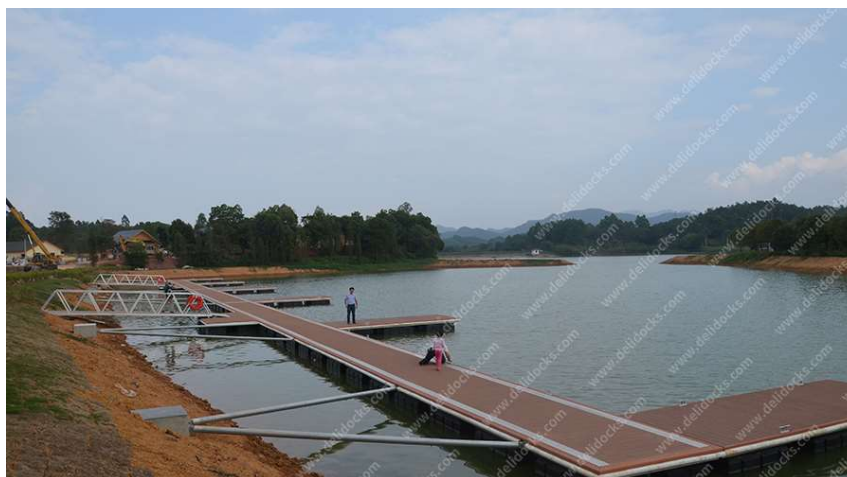
Slika 38. Sidrenje pomoću čeličnih ojačanja [37]
