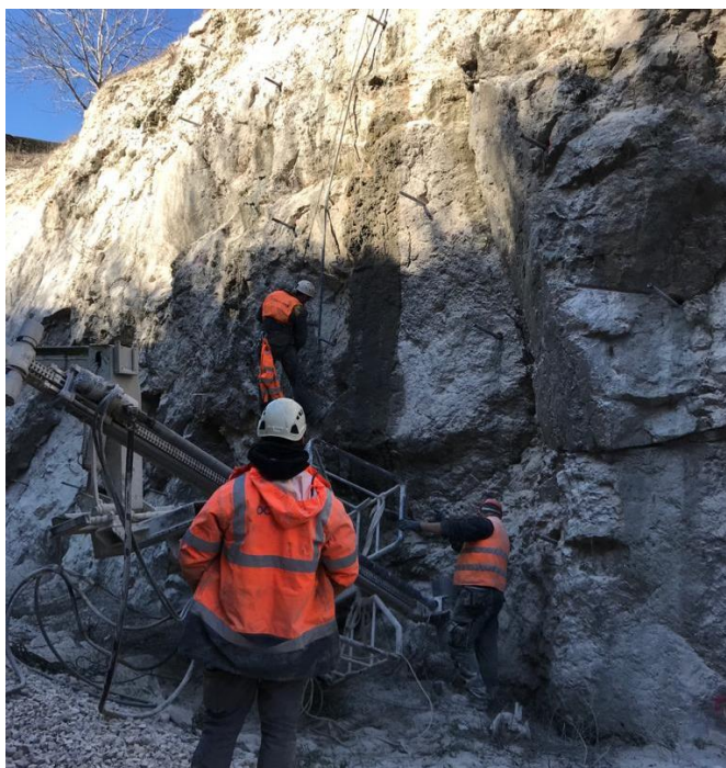
Slika 28 Ugradnja i injektiranje geotehničkih sidara (Foto L. Gašparić)
