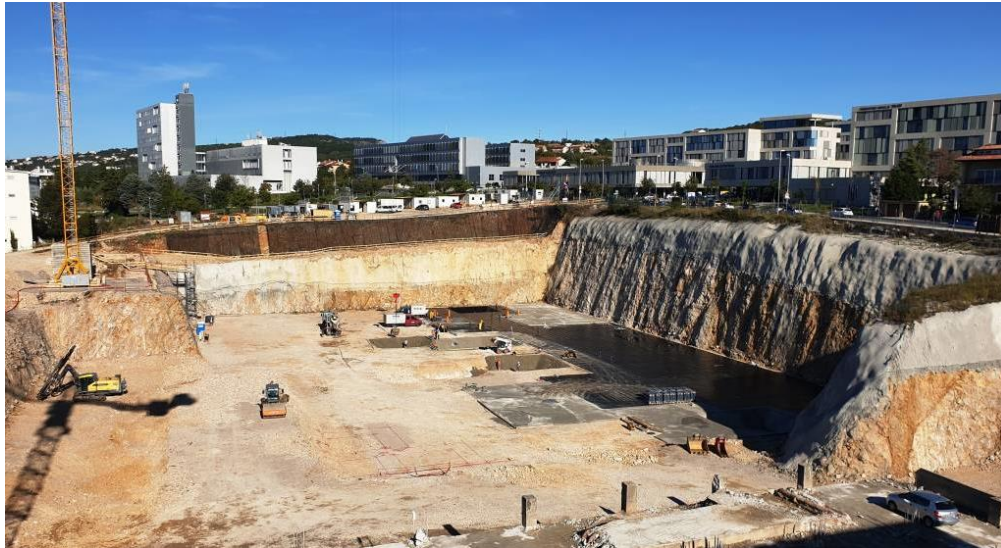
Slika 26 Pogled na sjeverni i zapadni pokos građevne jame KBC Rijeka (LiveCam Croatia, 2020)
