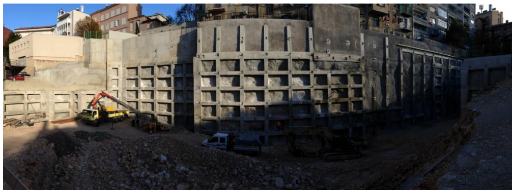
Slika 18 Izvođenje građevne jame Zagrad B (Monterra, 2020)
