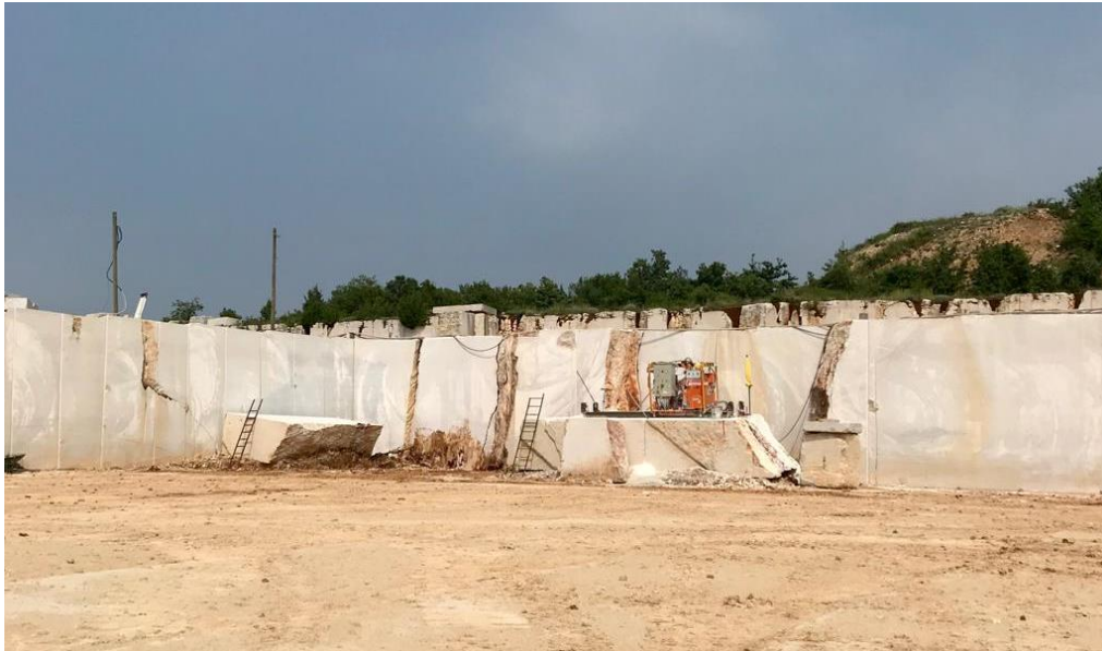
Slika 11 Stabilni zidovi pri iskopu stijenske mase u kamenolomu (Foto L. Gašparić)
