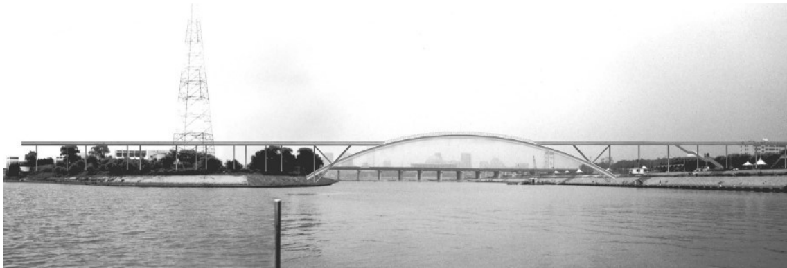
Abbildung 2.11: Gesamtansicht der Seonyu Fußgängerbrücke [13]
