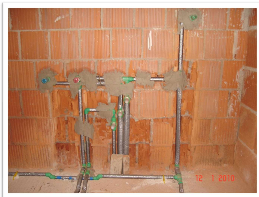
Slika 10 : Razvod cijevi za toplu i hladnu vodu [11]
