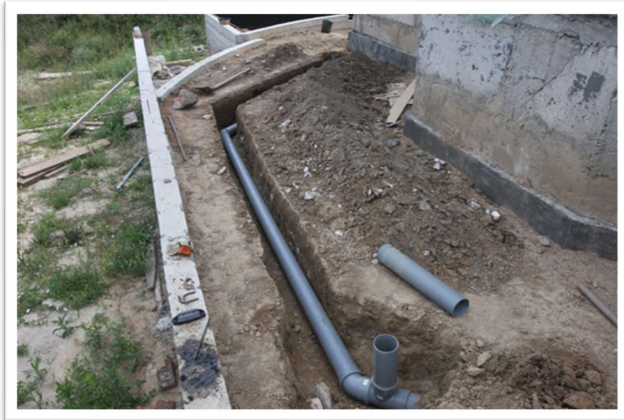
Slika 4: Postavljanje dvorišne kanalizacijske mreže [5]
