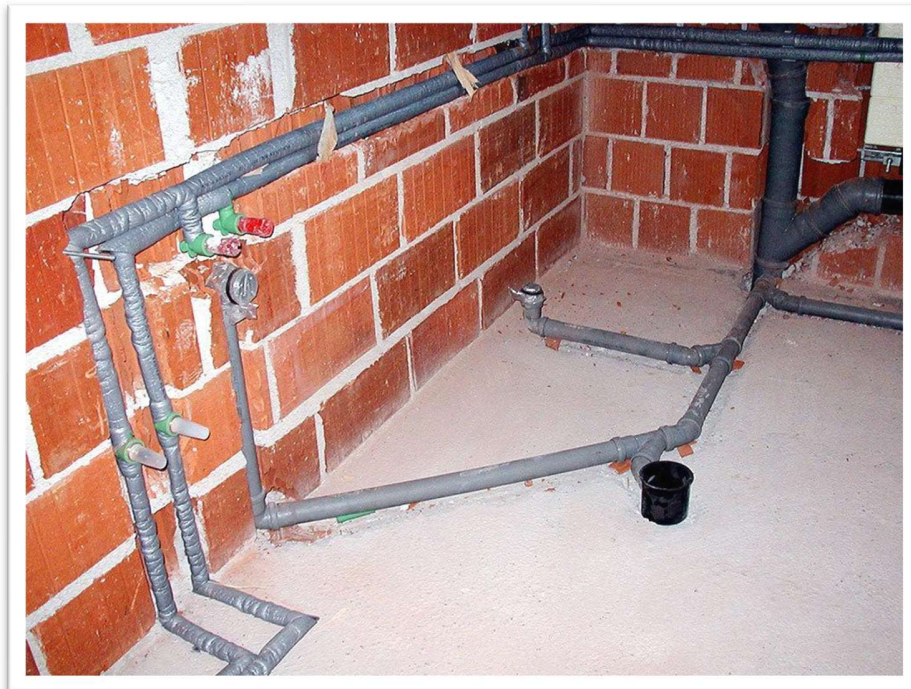
Slika 9: Razvod kućne vodovodne i kanalizacijske mreže [10]
