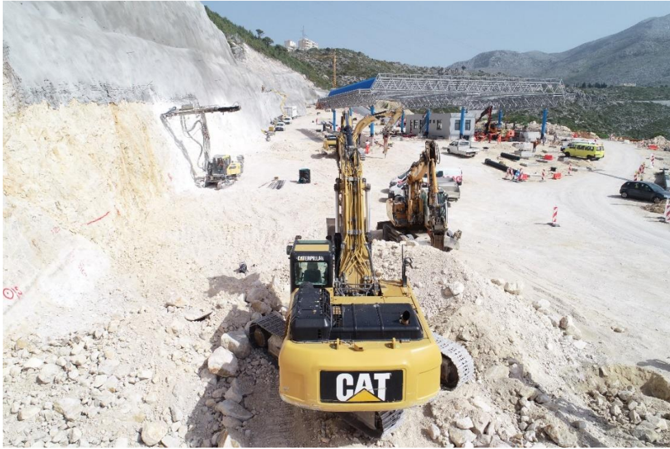
Slika 54 Bušenje sidara na posljednjoj vertikalnoj radnoj etaži (Foto: V. Damjanović)
