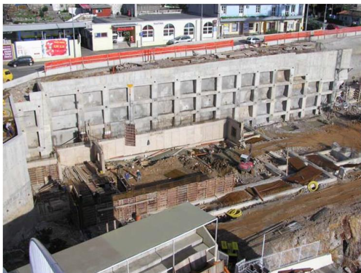
Slika 22 Pogled na izvedenu konstrukciju na građevnoj jami Kantrida u Rijeci (Arbanas et al., 2007) (Foto: T. Pap)
