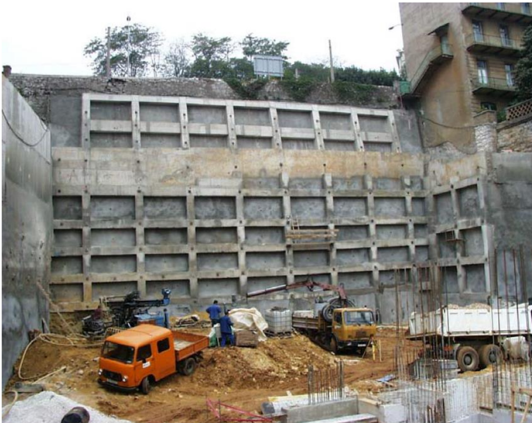
Slika 21 Završna faza izvedbe osiguranja pokosa na građevnoj jami Zagrad A u Rijeci (Arbanas, 2002) (Foto: Ž. Arbanas)
