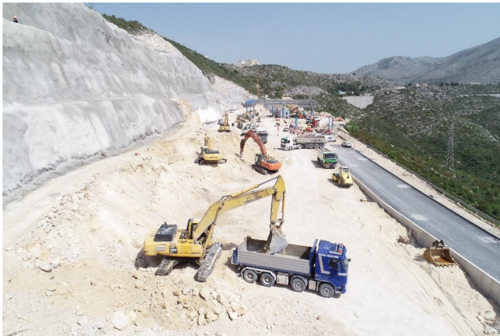
Slika 57 Iskop posljednje vertikalne radne etaže (Foto: V. Damjanović)
