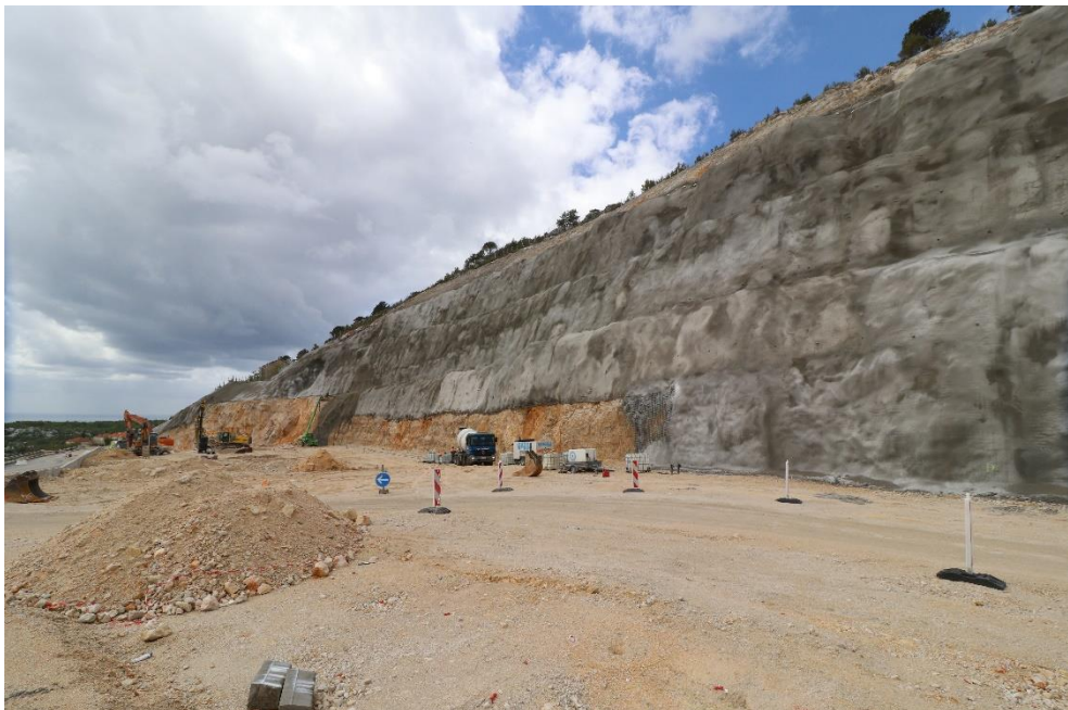
Slika 56 Izvedba mlaznog betona i procjednica na stijenskom pokosu (Foto: V. Damjanović)
