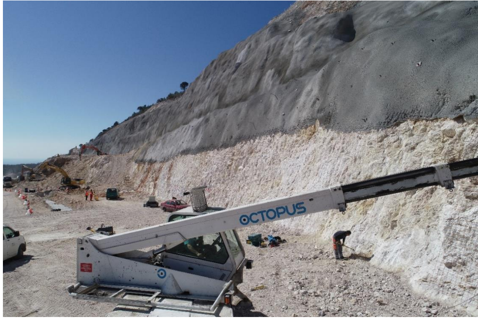
Slika 55 Izvedba završnog sloja mlaznog betona (Foto: V. Damjanović)
