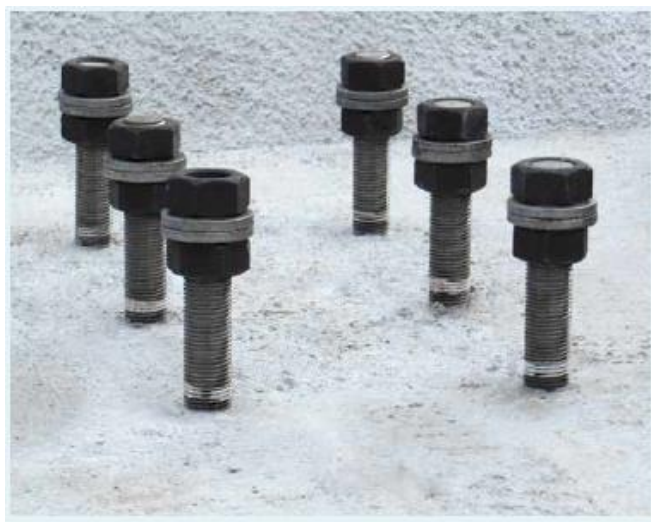
Slika 3: Sidreni vijci za spoj stupa i temelja [2]
